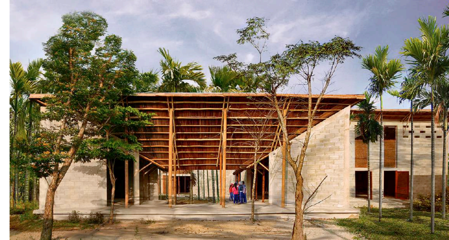
Figura 4.14 - Fachada do centro. Disponível em: < https://www.archdaily.com.br/881314/ >.
