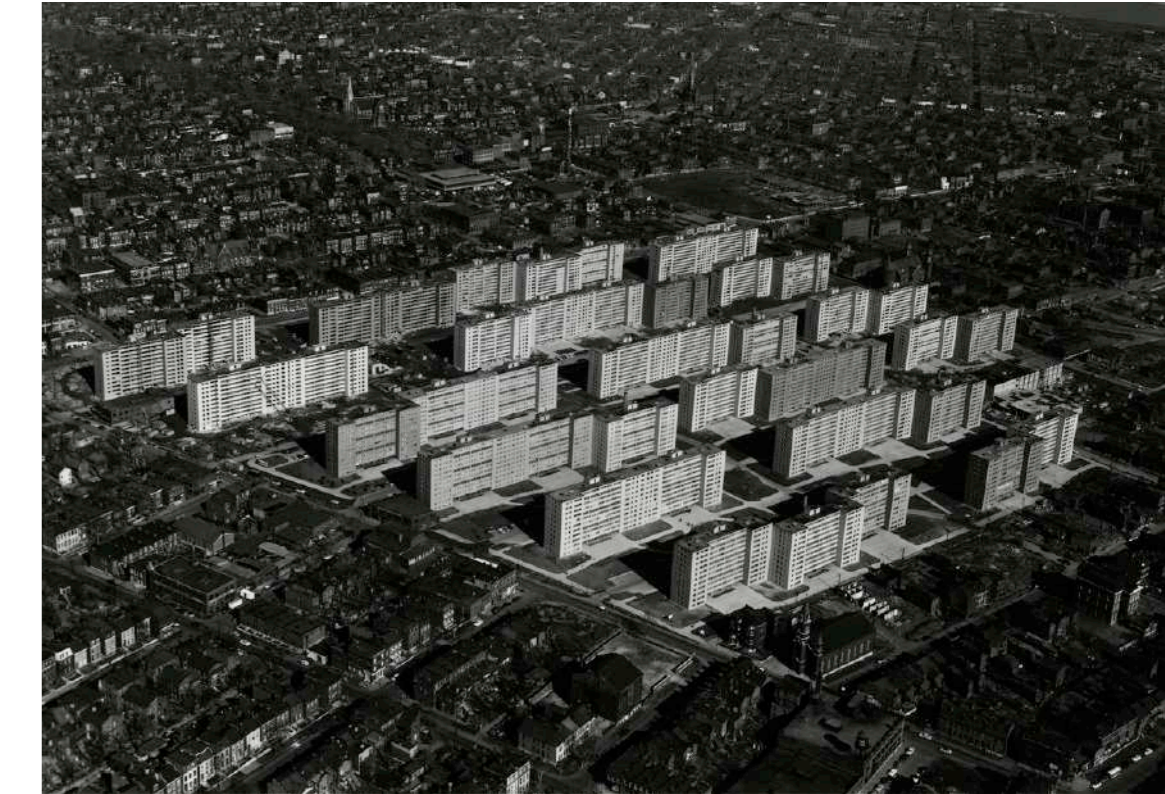
Figura 3.7 - Projeto habitacional de Pruitt-Igoe em (St. Louis, Missouri), projetado por Minoru Yamasaki. Parte de um programa federal de habitação social para famílias de baixa-renda, foi demolido em 1973. Disponível em: < https://www.archdaily.com.br/br/871669 >.
