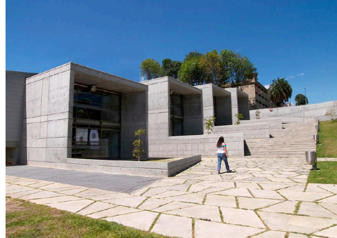
Figura 3.12 - Biblioteca San Javier, projeto de Javier Vera Arquitectos. Disponível em: < https://arquitecturapanamericana.com/parque-biblioteca-san-javier/ >.
