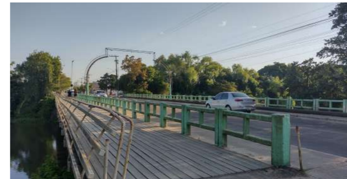
Figura 32: Ponte sob Arroio Duro Fonte: Acervo pessoal, 2022
