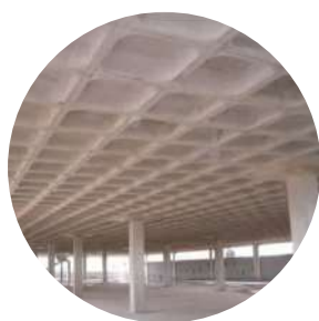
Laje nervurada e pilares de concreto
