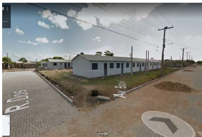
figura 08 - loteamento Ceval em construção (2012) fonte: Google Maps - Street View
