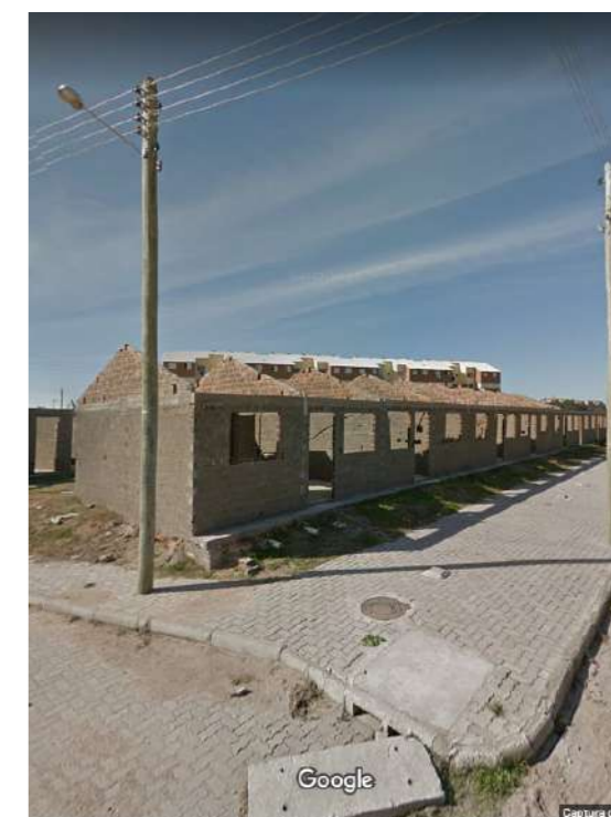
figura 15 - loteamento PAC/ Anglo em construção (2011) fonte: Google Maps - Street View
