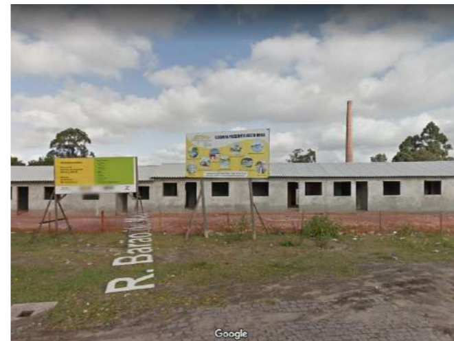
figura 13 - loteamento Barão de Mauá em construção (2011) fonte: Google Maps - Street View
