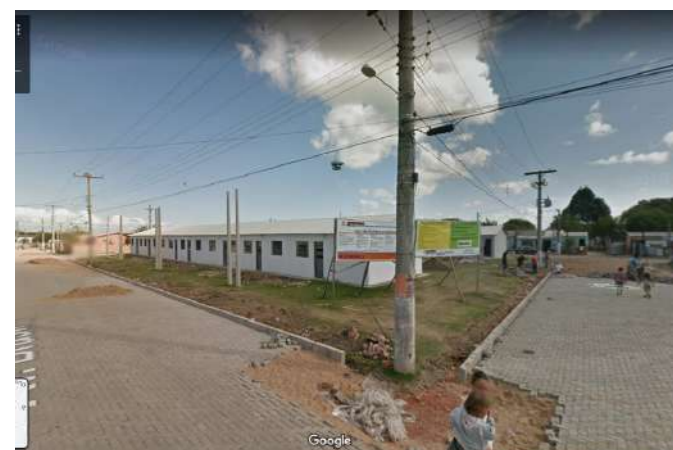
figura 10 - loteamento Ceval em construção (2012) fonte: Google Maps - Street View
