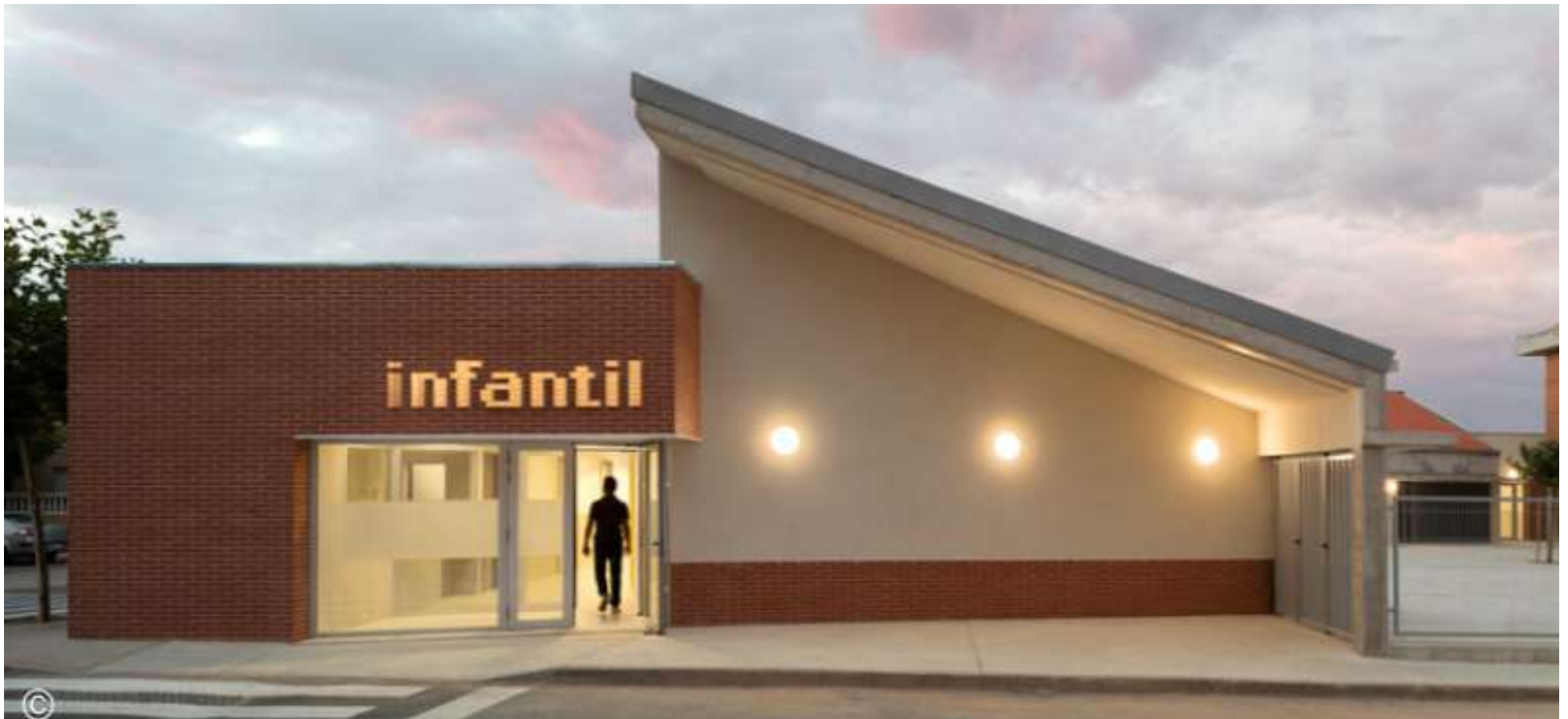
Figura 27. Fachada principal da Escola Infantil de Cariñena
