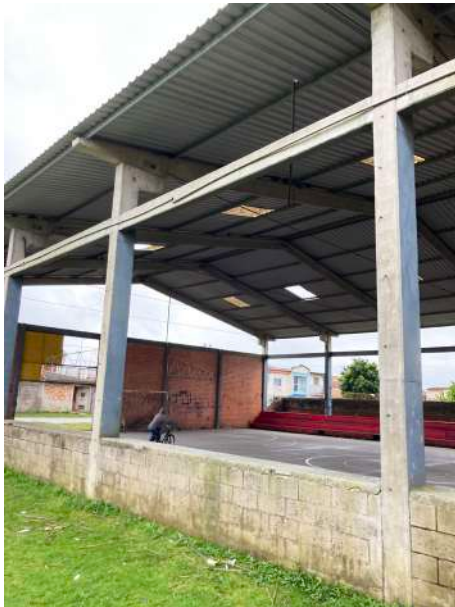
Figura 05.2.1: os pilares que serão mantidos fonte: autora, 2022.
