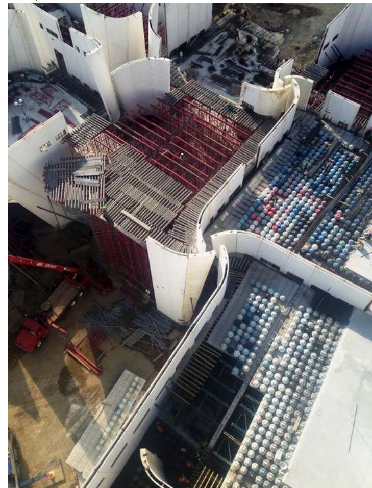
Imagem do processo de concretagem das lajes do Museu Internacional do Barroco. Fonte: Archdaily
