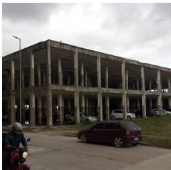
ZONA ANGLO - Aspecto Negativo: sem manutenção, difícil estacionamento
