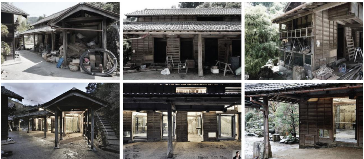
Figura 4. Fotografias Apresentadas nas Pranchas: na primeira linha as imagens externas antes da intervenção; na segunda, após a intervenção. Fonte: desenvolvidas pelo escritório Issei Suma , Japão para Premio Internazionale Domus di Restauro e Conservazione , 2015. Disponível em: https://www.premiorestauro.it/en/ . Acesso em: 1 out. 2021.
