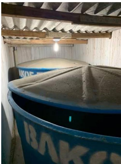
Figura 30 – Foto dos reservatórios superiores do ginásio do complexo esportivo com volume de 5.000 litros.
