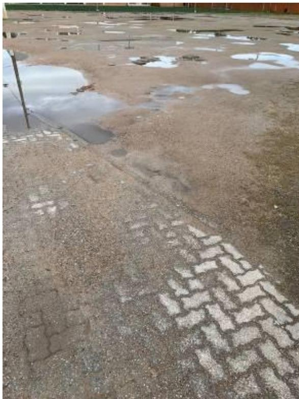
Figura 17 – Foto da situação do estacionamento localizado na área externa dentro do complexo esportivo em dias chuvosos.
