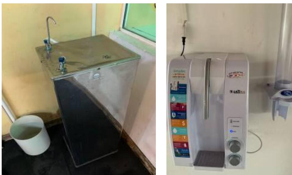
Figura 6 – Foto dos bebedouros presentes na academia, um deles ligado direto na rede de abastecimento oferecida pelo SANEP (esquerda), e o outro, ligado diretamente no reservatório de água local (direita).
