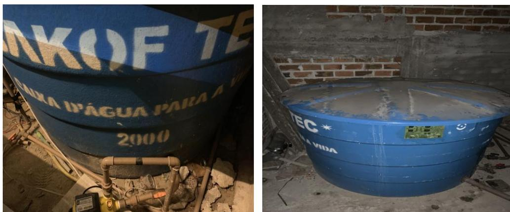
Figura 4 – Foto dos reservatórios academia. À esquerda o reservatório inferior que é abastecido pelo SANEP e a direita um dos dois reservatórios superiores localizados em cima do banheiro feminino, ambos com 2.000 litros.
