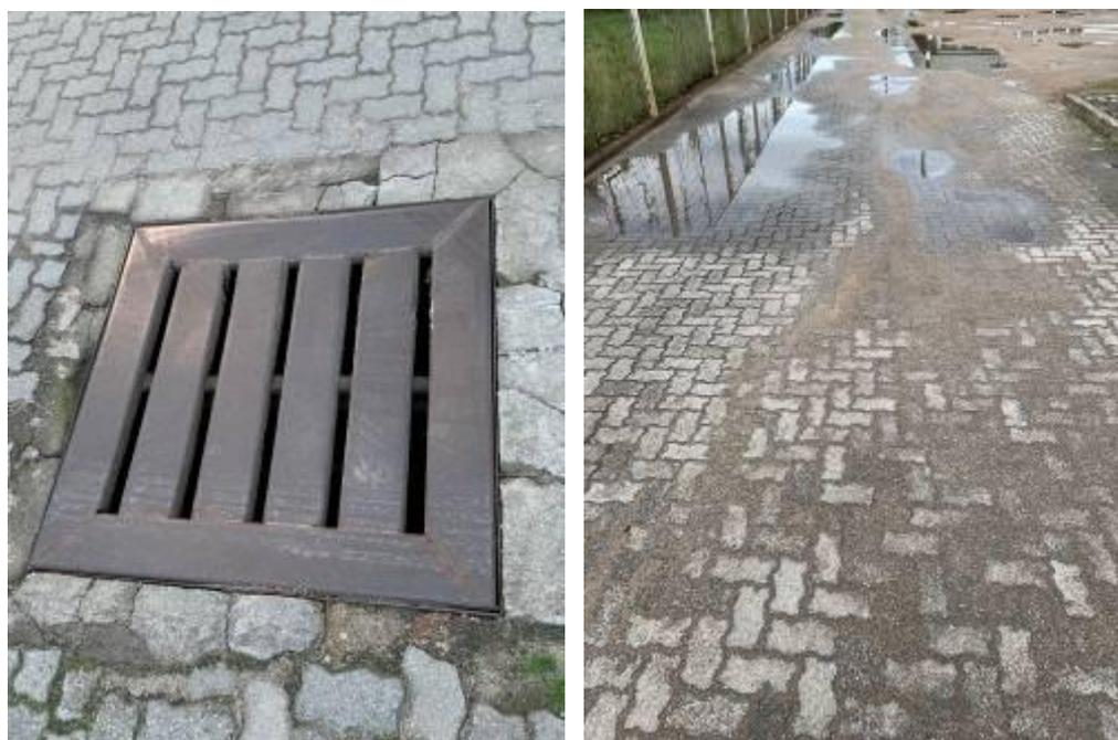
Figura 18 – Foto da caixa de drenagem (esquerda) e do pavimento (direita) existentes no acesso ao complexo esportivo e a situação em dias chuvosos.
