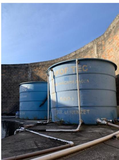
Figura 5 – Foto do reservatório localizado na parte superior do banheiro masculino com volume de 5.000 litros.
