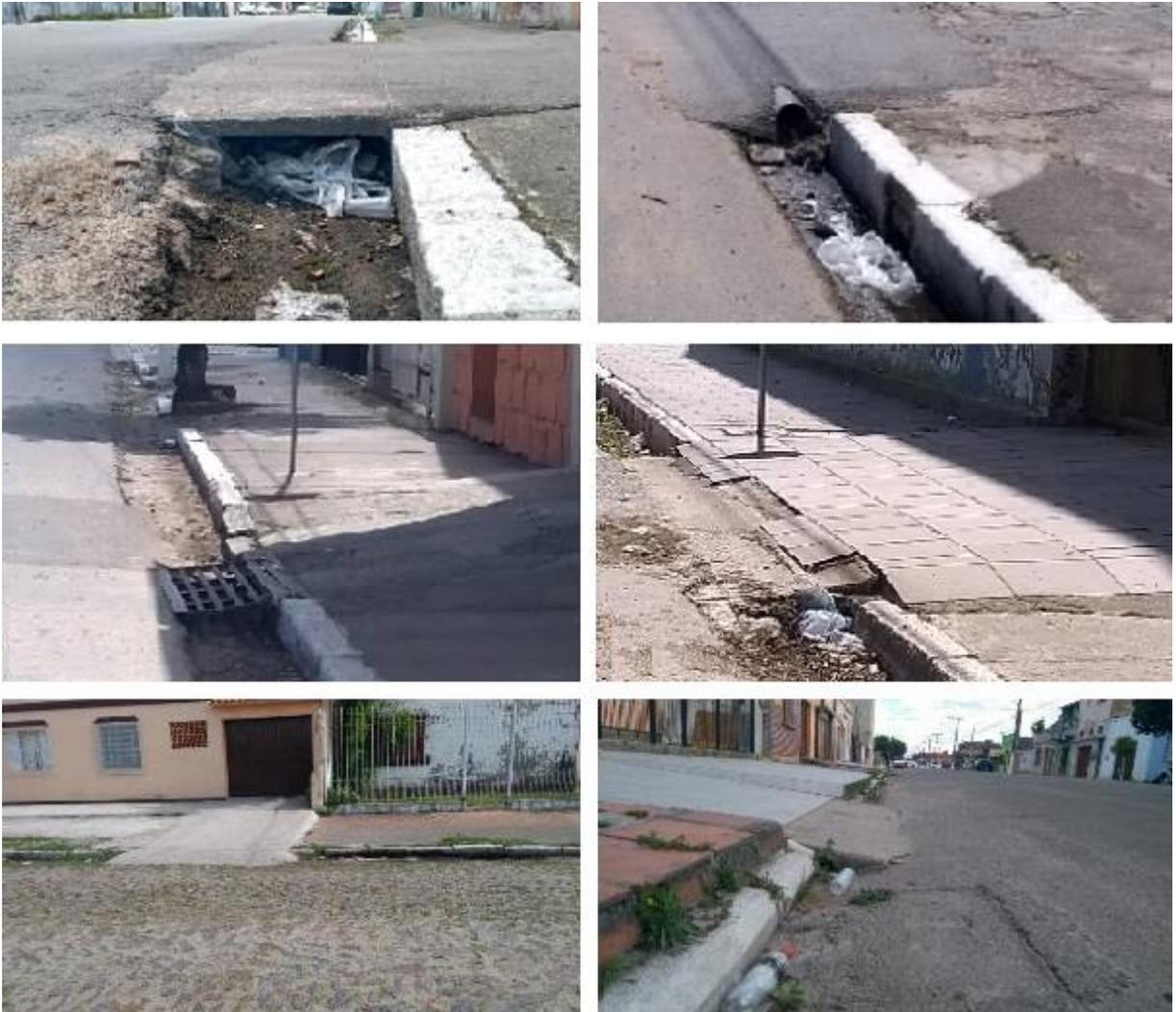
Figura 36: Rampas inadequadas observadas no bairro Porto.
