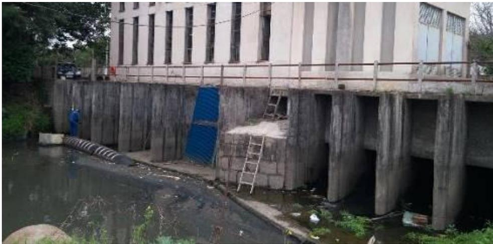
Figura 5: Responsável pela manutenção da casa de bombas removendo os resíduos retidos nas grades.
