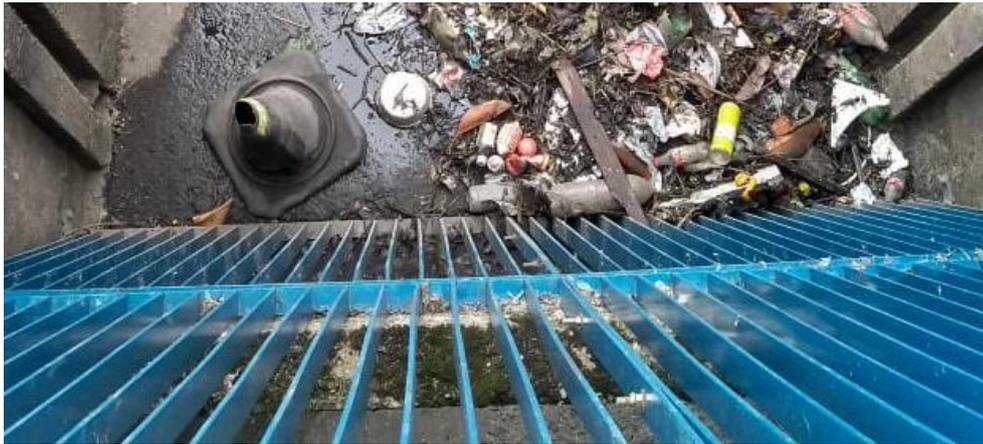
Figura 4: Grades de contenção da Casa de Bombas do Anglo.
