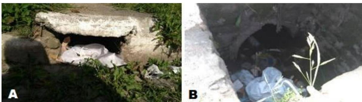
Figura 34: (A) Entrada da boca de lobo com resíduos. (B) Interior da boca de lobo com resíduos.
