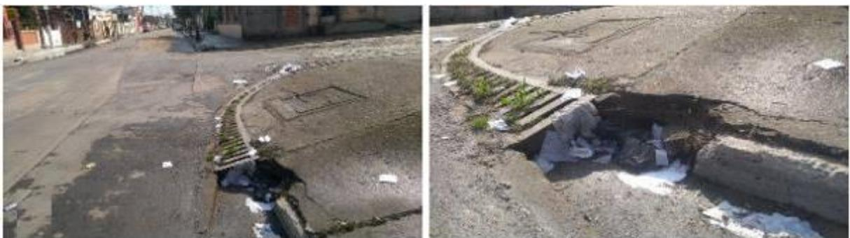
Figura 32: Bocas de lobo de sarjeta com a presença de resíduos.
