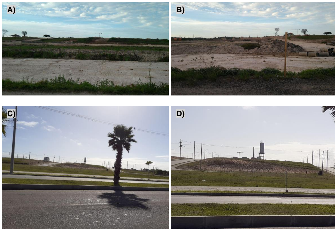
Figura 46 - Registro fotográfico de campo mostrando algumas etapas relacionadas à expansão urbana na área de estudo. A Figura A e B evidenciam algumas etapas de obras realizadas em 19/09/2019. A Figura C e D evidenciam as etapas atuais em relação às obras que estão sendo executadas na área de estudo em 15/04/2022.
