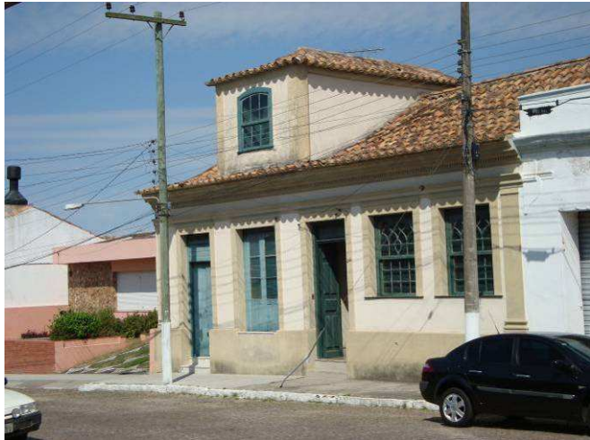
Figura 62: Edificação de características luso-brasileiras. Autor: Anna Finger. 2009.
