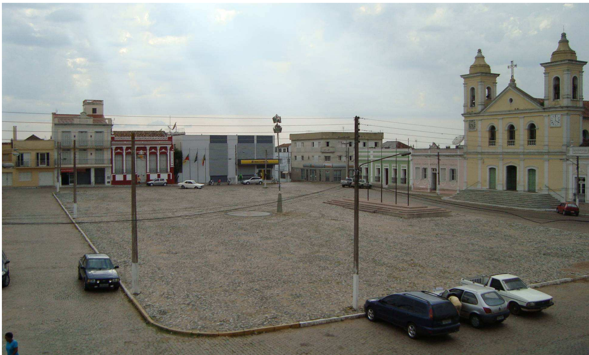
Figura 75: Vista geral da Praça Alcides Marques. Autor: Anna Finger, 2009.
