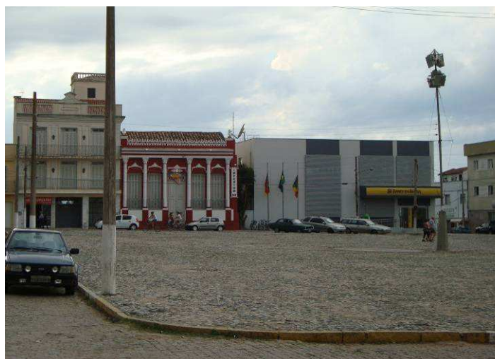
Figura 61: Vista atual do edifício do Banco do Brasil Autor: Anna Finger, 2009.
