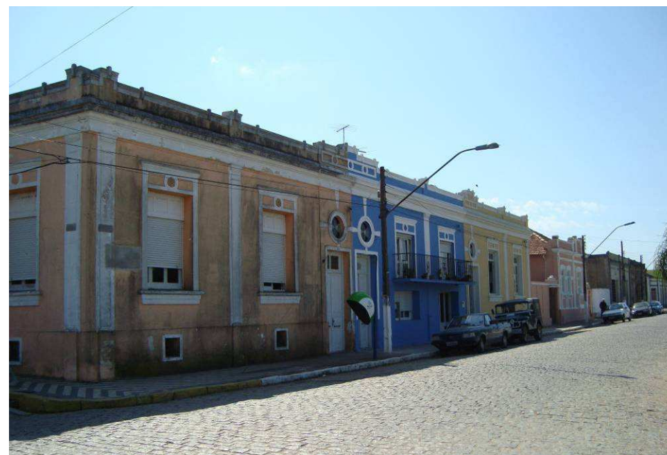
Figura 65: Conjunto de edificações situadas à Rua 20 de setembro, na margem do Rio Jaguarão. Autor: Anna Finger, 2009.
