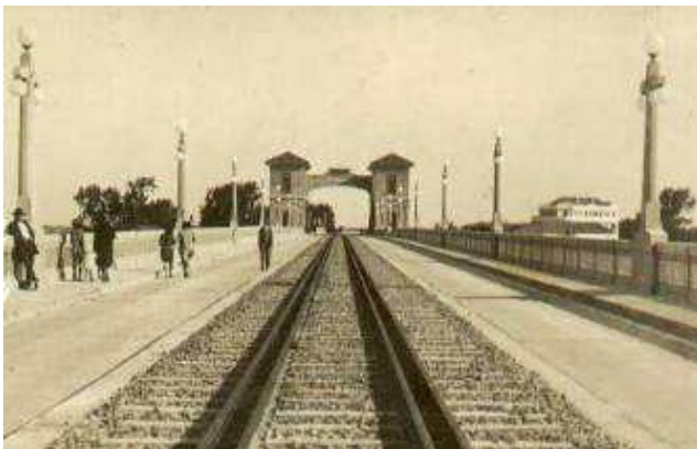
Figura 51: Ponte Internacional Mauá. Fonte: Instituto Histórico e Geográfico de Jaguarão, sem data.
