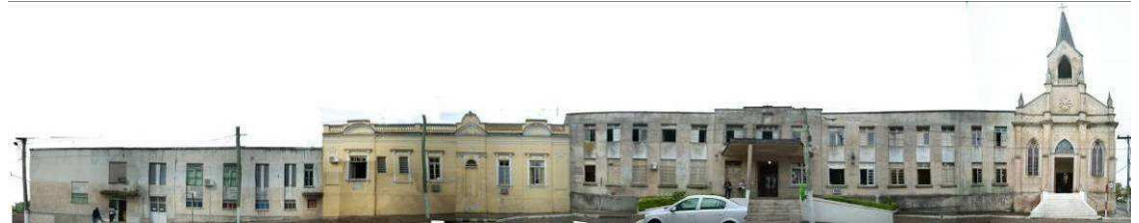
Figura 141: Montagem do conjunto da Santa Casa de Misericórdia. Autor: Simone Neutzling, 2009.
