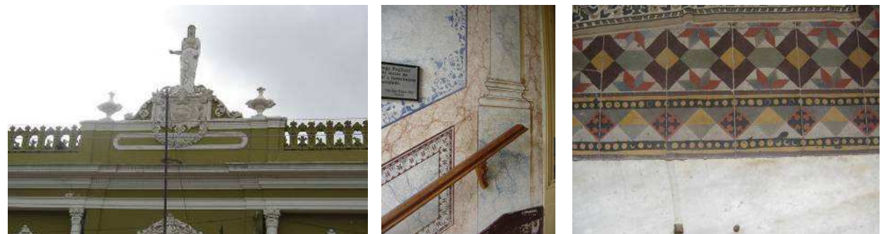
Figuras 72: Detalhes das platibandas e escaíolas internas. Autor: Simone Neutzling, 2009.
