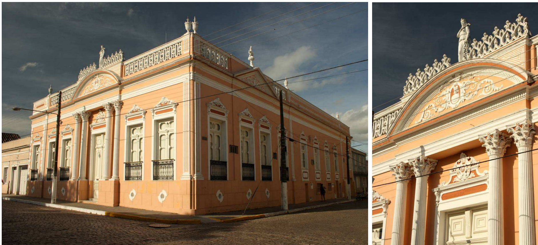
Figura 73 e 69: Vista e detalhe de edificação situada no entorno da Praça Alcides Marques. Autor: Eduardo Tavares, 2009.
