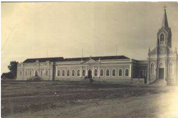
Figuras 138 e 139: Santa Casa no início do século XX e após a construção da capela (à direita) e do anexo (à esquerda do corpo principal do edifício). Fonte: Instituto Histórico e
