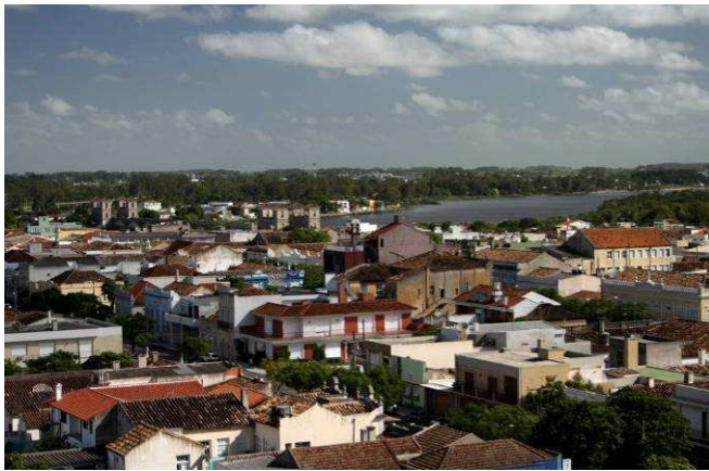
Figura 56: Vista geral de Jaguarão. Observa-se a predominância de edificações térreas ou com dois pavimentos. Autor: Eduardo Tavares, 2009.
