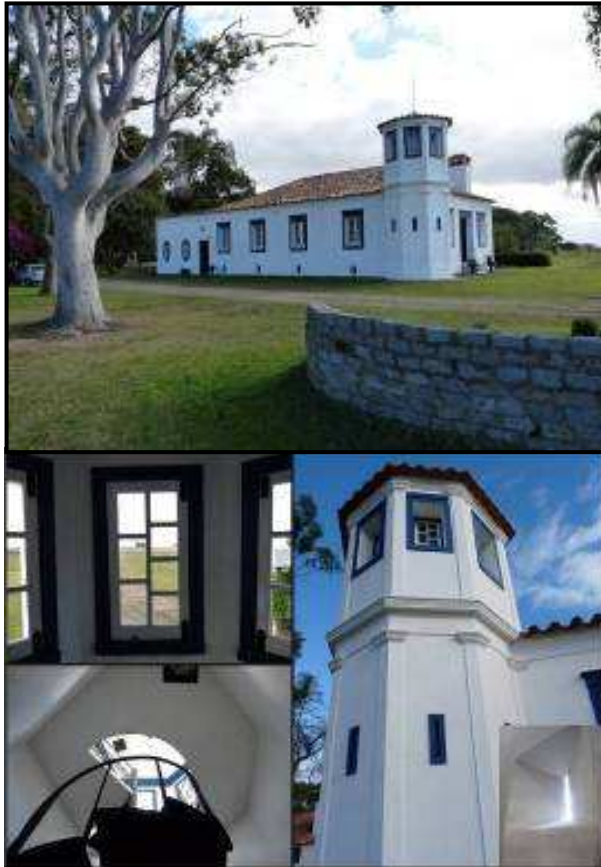
Figura 13: Fazenda São João. Apesar da descaracterização sofrida pelo torreão com a abertura de janelas, observa-se ainda a configuração de mirante e as seteiras para tiro. Foto: Simone Neutzling, 2009.
