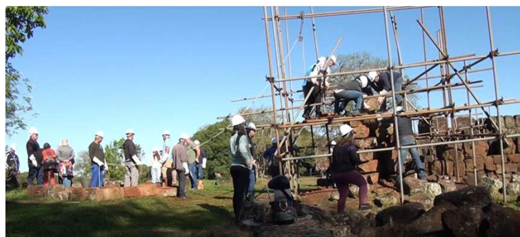
Figura 13: Aula prática de consolidação de parte dos remanescentes da adega de São Miguel.
