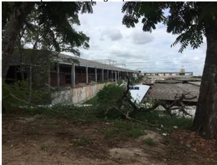
Figura 03: Construção do Shooping Popular no Centro de Abastecimento
