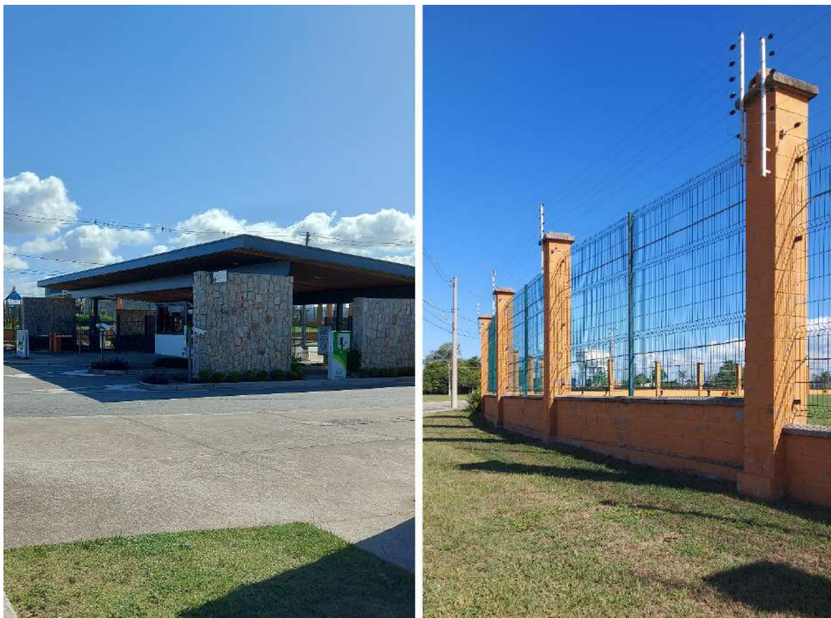
Figura 37 - Guarita de acesso e fechamento do condomínio Alphaville Pelotas. Fonte: Da autora, 2023.
