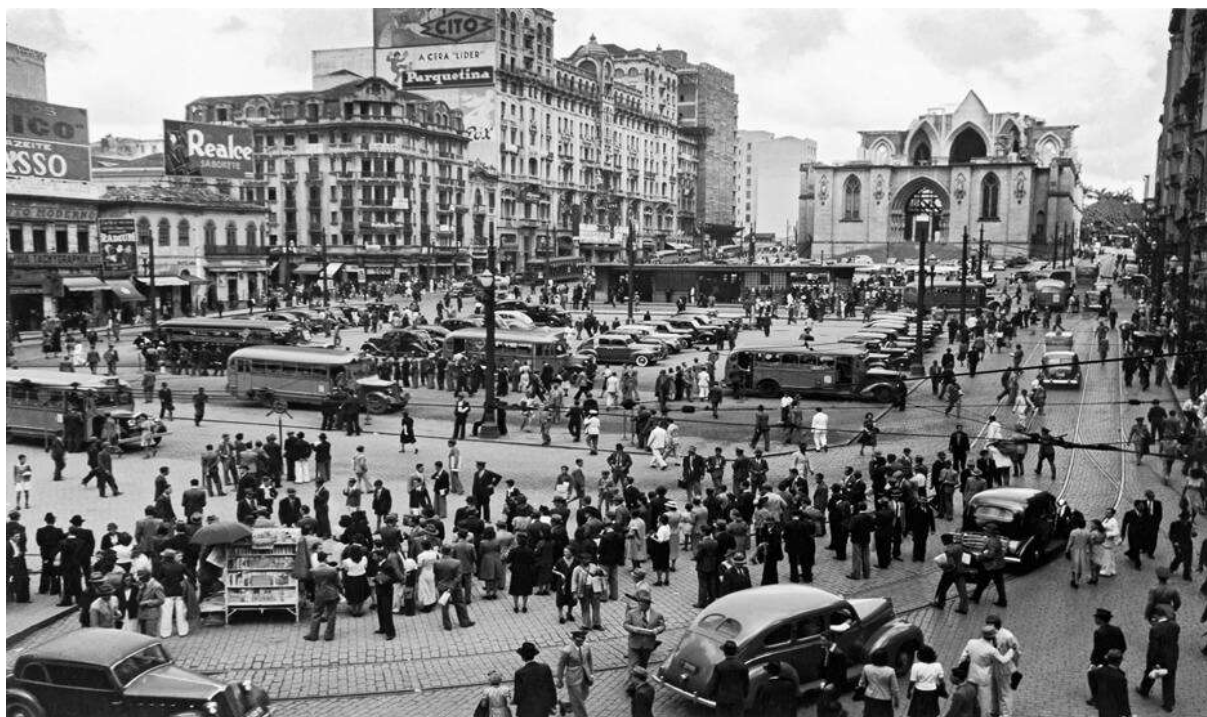
Figura 4 - A cidade de São Paulo na década de 1940. Largo da Sé e a Catedral sendo construída. Fonte: Foto de Hildegard Rosenthal. Acervo do Instituto Moreira Salles.
