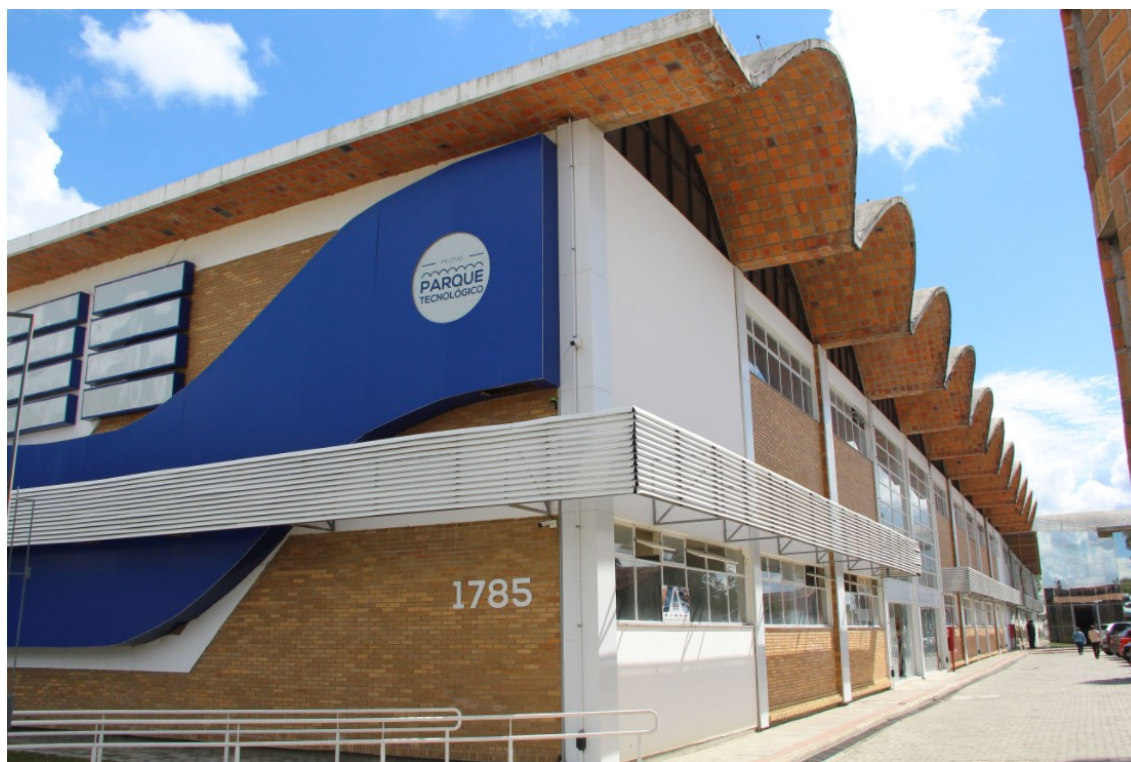
Figura 3 – Instalações prediais do Pelotas parque tecnológico Fonte: Pelotas (2021)
