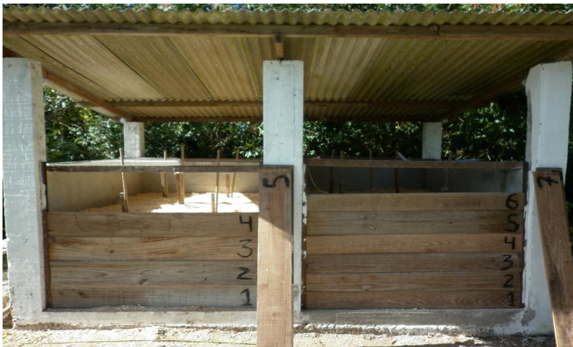
Figura 2 - Parte frontal da composteira constituída de porta com tábuas móveis. UFPel, Pelotas, RS, 2011.
