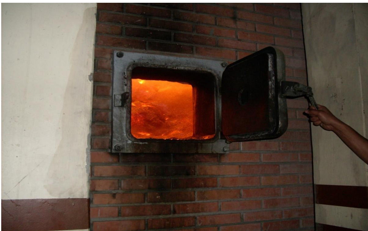
Figura 3 – Cinza de casca de arroz sendo queimada no forno para aquecimento da caldeira (UFPEL, 2010).
