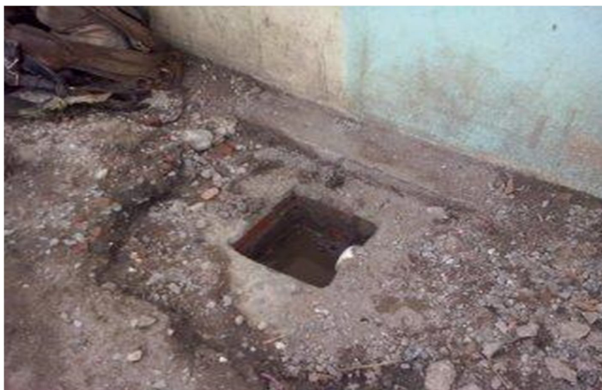
Figura 8: Dreno construído pelo morador Réferson, pois o sistema de esgoto não estava funcionando. Fonte: arquivo pessoal
