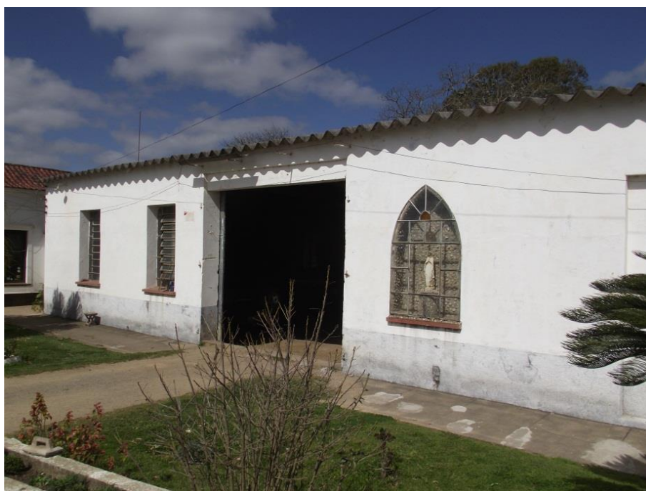
Figura 43 - Prédio da antigo Salão Brasil (5º distrito - Cascata) – Fonte: Foto da autora, 2011.
