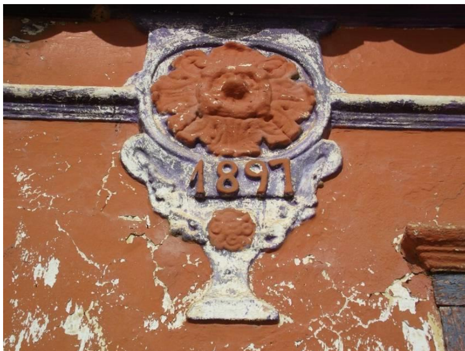
Figura 50 - Detalhe do prédio salão Cascatense - Fonte: Foto da autora, 2011.
