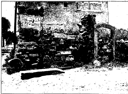
Fig. 69. — Trozo de muro de la casa del Virrey, de piedra grisácea. Obsérvese la entrada formada por jambas y arco escarzano monolíticos. Dimensiones: m. 12 x 18
