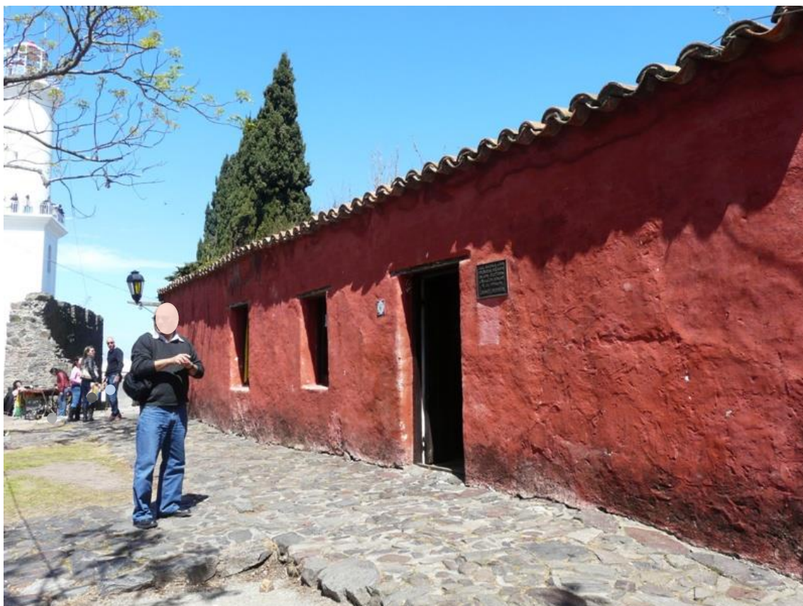
Figura 25 - Museo Casa de Nacarello en la actualidad, restauración 1993 a cargo del arquitecto Antonio Cravotto
