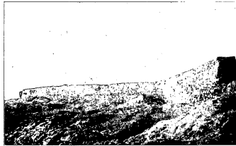
Fig. 32. — Murallas. Vista A
