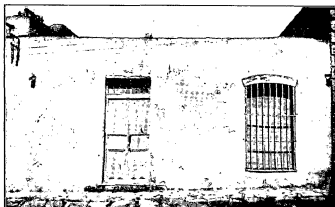
Fig. 111. — Casa calle Solís
