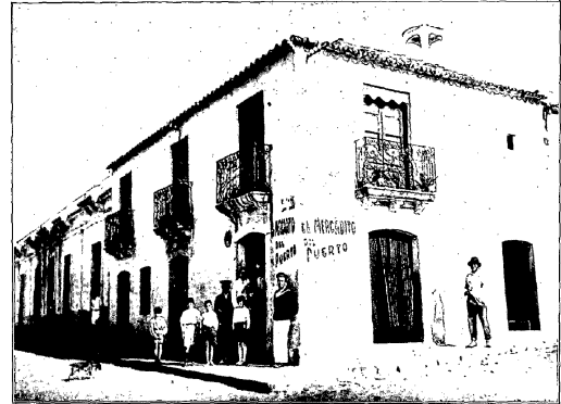
Fig. 72.— La llamada casa de Mitre, esquina calles San José y Treinta y Tres
