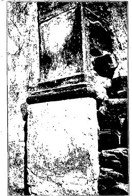
Fig. 88. — Detalle palastras de piedra de la fachada
