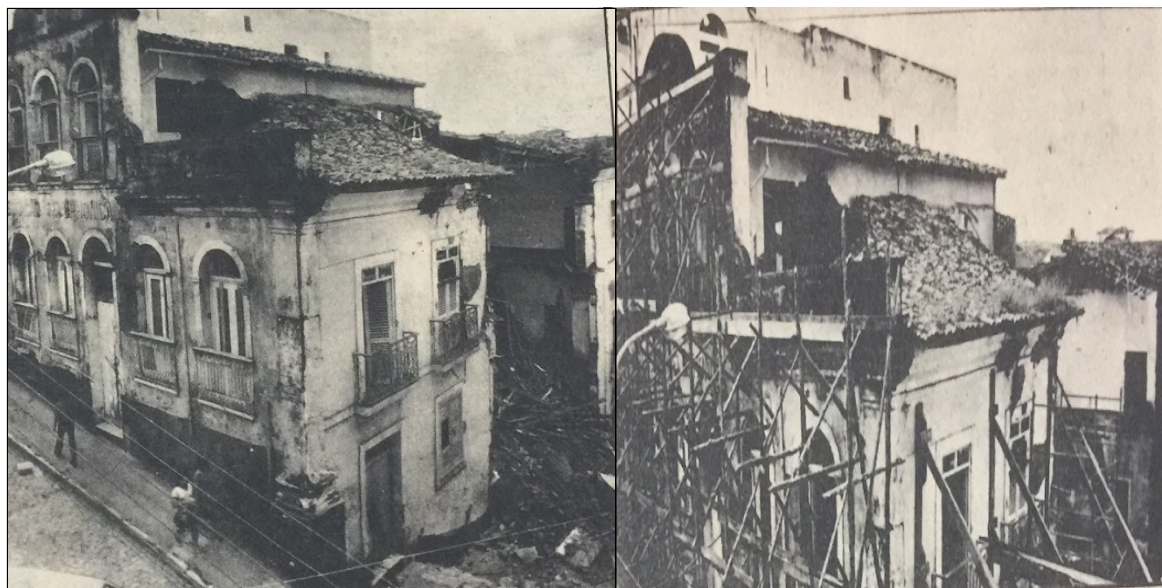
Figura 57 - Sobrado sede da Companhia Telefônica do Maranhão, 1986. Fotografia da antiga sede da Telefônica, na rua de Nazaré, após desabamento de parte do telhado. Fonte: O Imparcial, 19 de janeiro de 1986.
