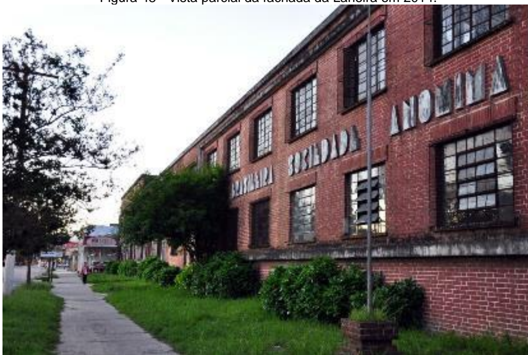
Figura 48 - Vista parcial da fachada da Laneira em 2014.
