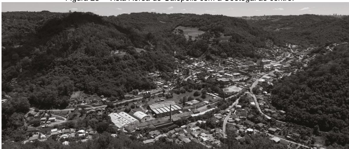
Figura 23 – Vista Aérea de Galópolis com a Cootegal ao centro.
