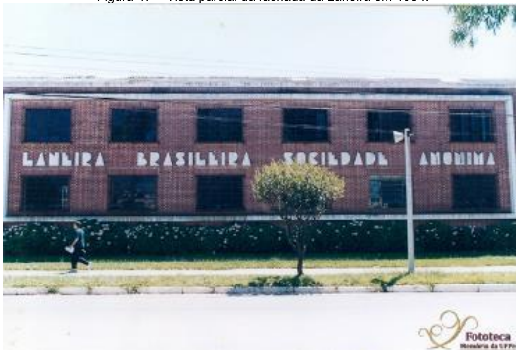
Figura 47 – Vista parcial da fachada da Laneira em 1994.
