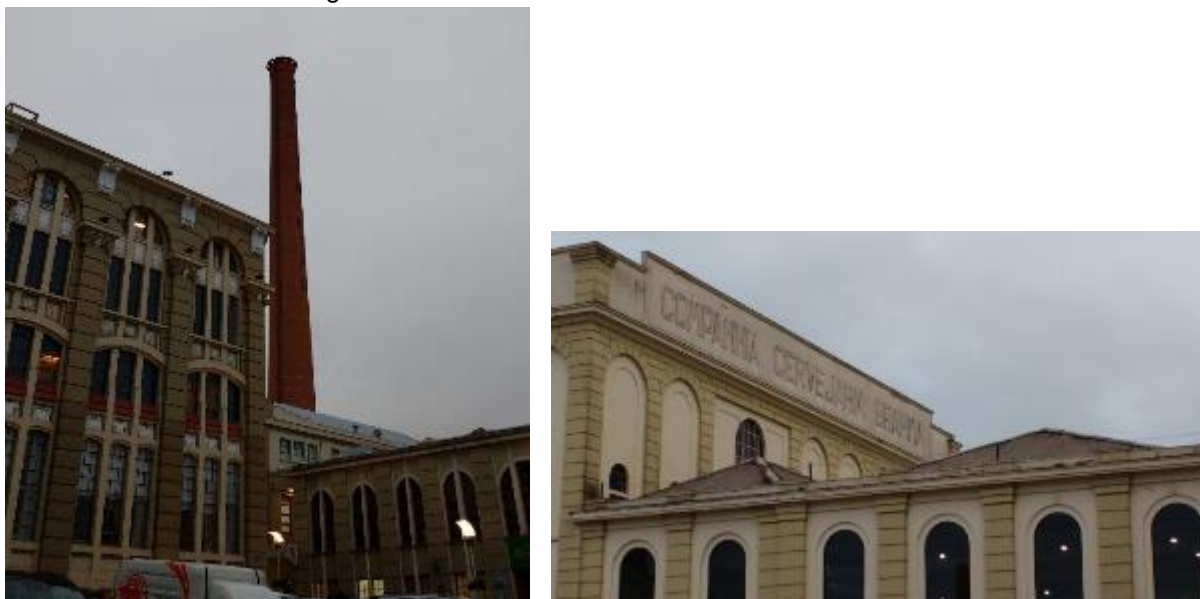
Figuras 35 e 36 – Chaminé e o Letreiro da fachada.
