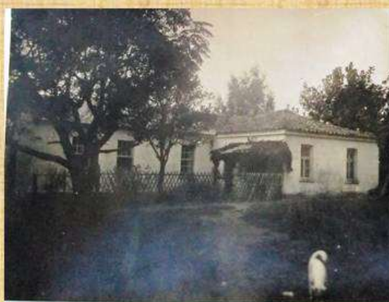
Schulgebäude und Pfarrwohnung zu São Domingos. A. 1931.
