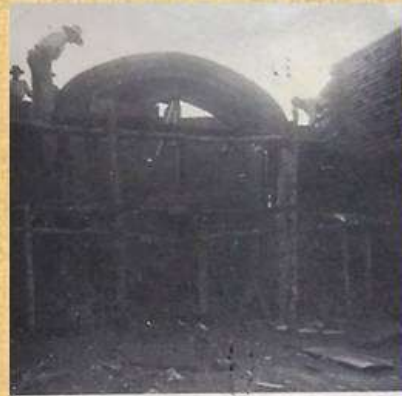
Der Altarbogen im Bau.
