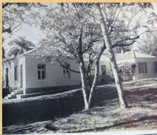
Das ganze Schulgebäude im April 1933.
