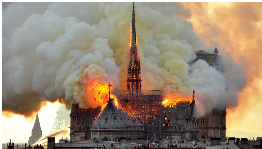
Figura 2 - Em cerca de uma hora a Flecha, inserida na restauração de Le-Duc, despencou, restando apenas uma pequena parte da porção superior da edificação.
