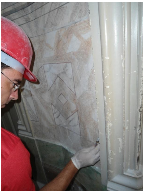
Figura 67 - Aluno do Bacharelado em Conservação e Restauração da UFPel restaurando uma escaiola Fonte: Acervo Marsou Engenharia
