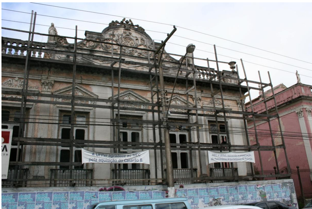
Figura 64 – Fachada Principal da Casa do Conselheiro com faixas, nas quais a UFPel agradece ao MEC pela aquisição do Casarão 08 Fonte: Acervo Fabio Galli, 2008.
