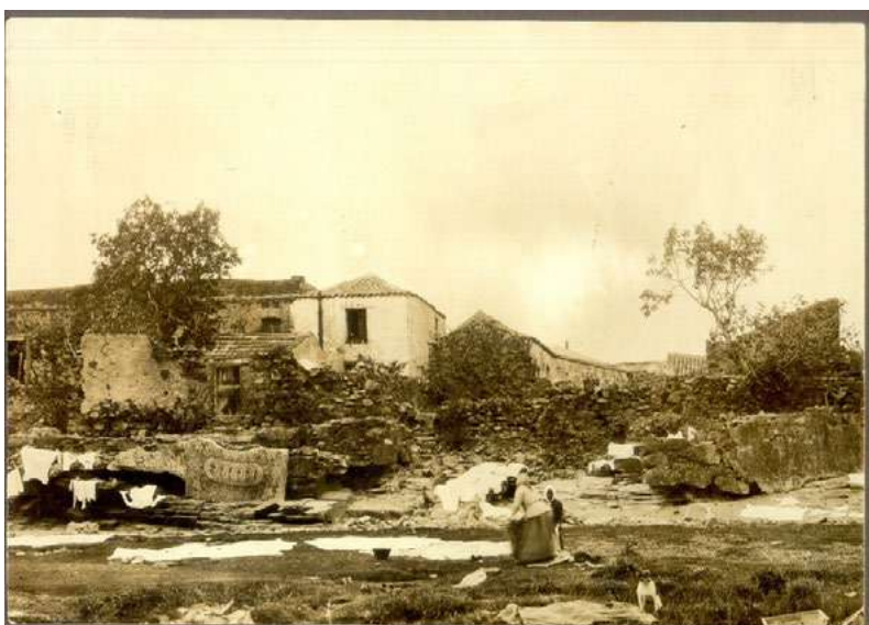
Figura 3: Viviendas asentadas sobre las ruinas de la muralla presumiblemente en la zona sur del área histórica (s/f)
