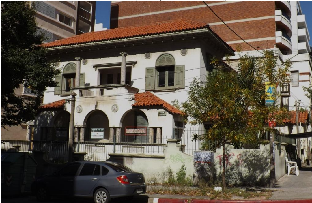
Fotografía 5 - La reinterpretación de lo colonial en la arquitectura uruguaya de los años 20. Casa Casabó (Villa Sta. María de la Gracia) del arquitecto Julio Vilamajó, 1925. Montevideo
