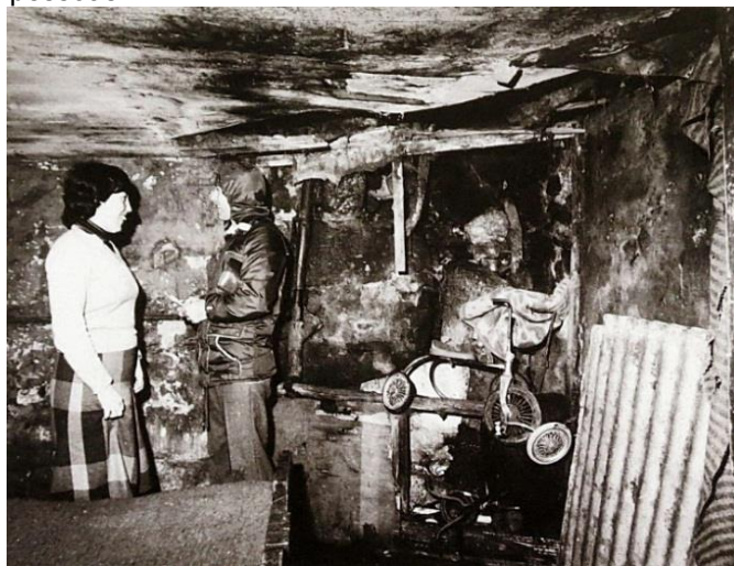
Figura 2 - Aspecto do interior de habitação degradada, na década de 1960, no Barredo Porto, Portugal. “Não entrava sol, era uma cave húmida onde vivíamos 14 pessoas”.
