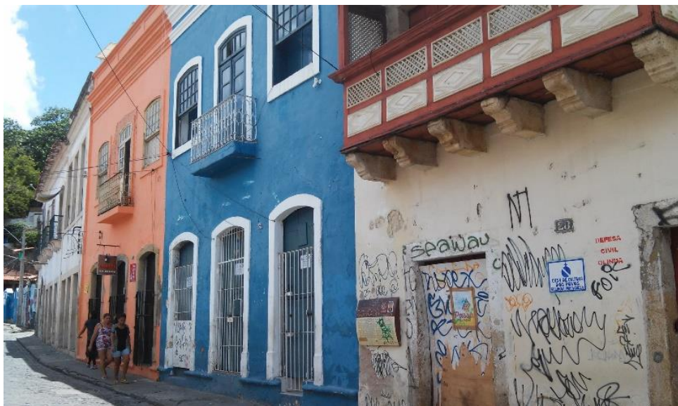
Figura 57- Problema de “pichações” nos imóveis
