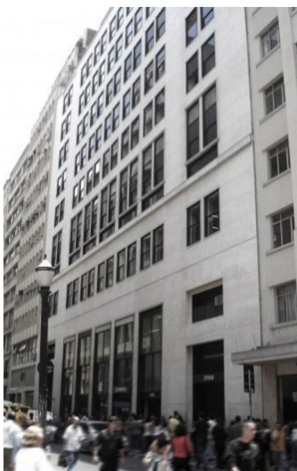
Figura 14 – Fachada do Edifício Guilherme na Rua 7 de Abril
