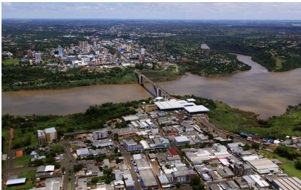
Figura 2 – Ponte da Amizade na fronteira entre o Brasil e o Paraguai. Fonte: Disponível em: < http://jie.itaipu.gov.br/node/42674 >acesso em: 26/02/2017.
