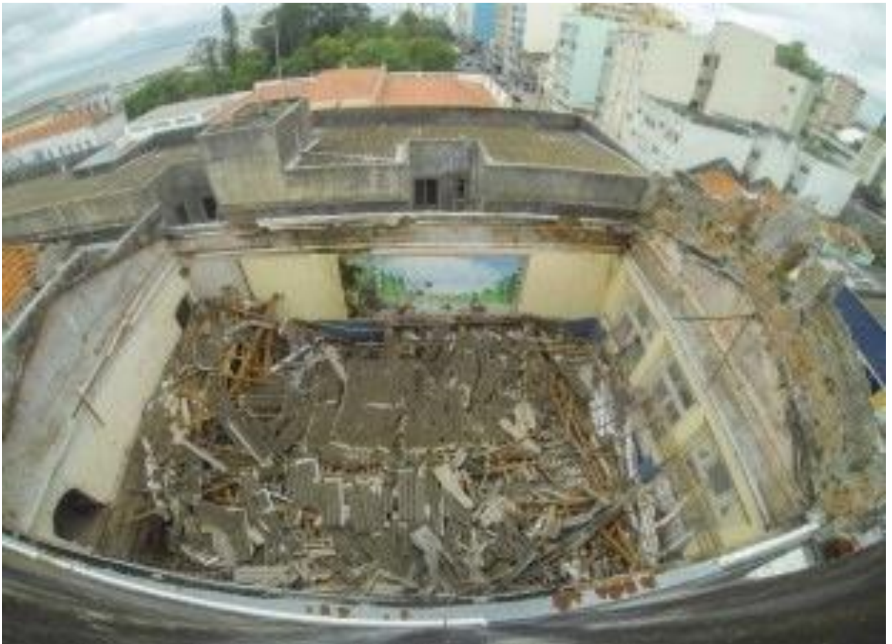
Figura 2: Desabamento do telhado do CCRG. Jornal Diário Popular. Fotografia: Marcus Maciel. Acesso: 1º/04/2014
