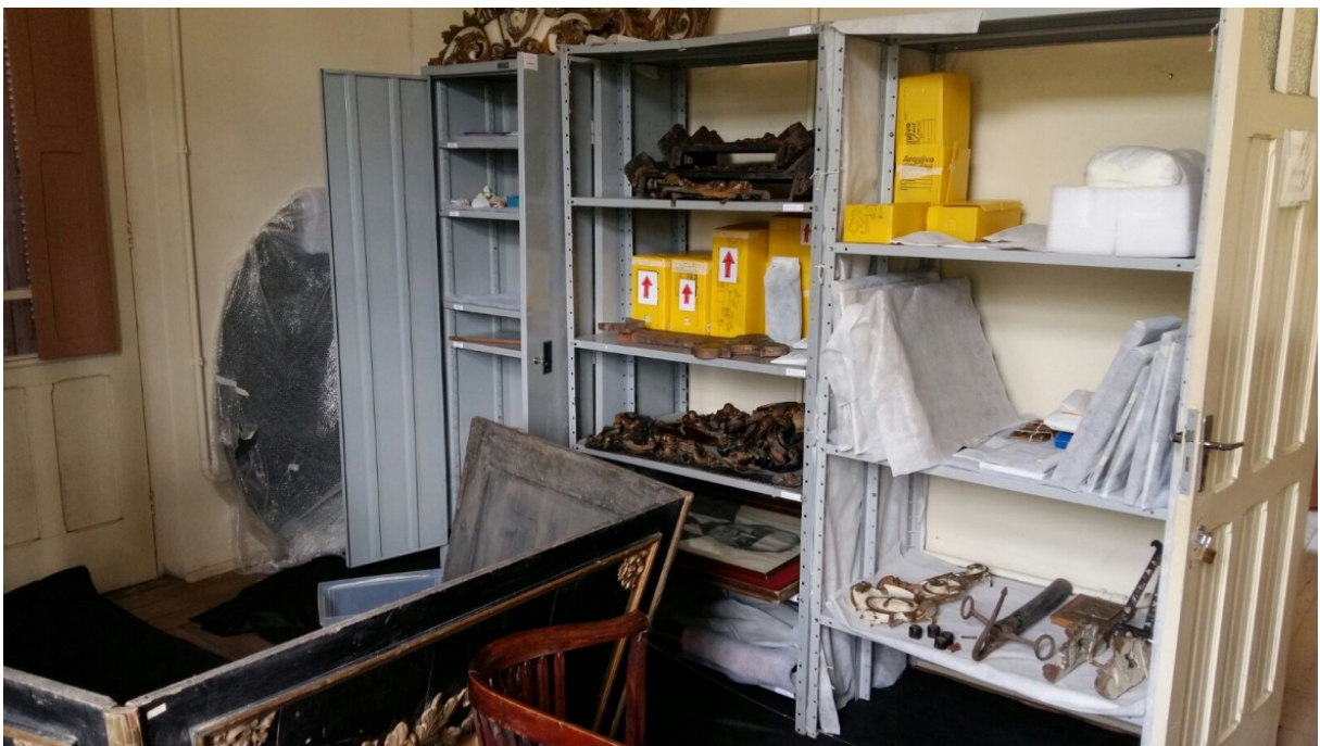
Figura 82: A imagem mostra onde eram armazenados o mobiliário, peças em metal e gesso na RTIII da Vila Stella.
