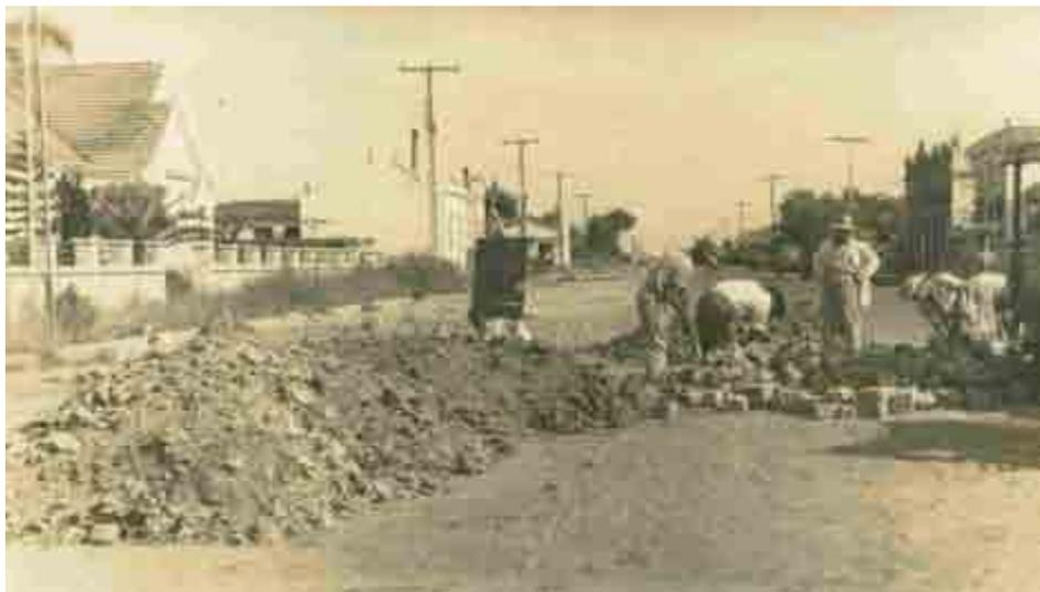
Figura 23 – Avenida Argentina. Pelotas. RS. Pavimentação com paralelepípedo. 1959.
