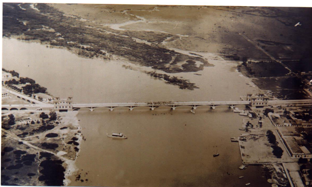
Figura 7: Vista aérea da ponte no momento da sua inauguração. Fonte: Instituto Histórico e Geográfico de Jaguarão.
