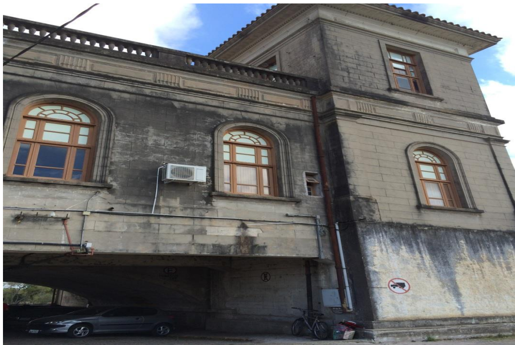
Figura 13: Imagem do edifício aduaneiro Brasil; Fonte: a autora, maio/2015.
