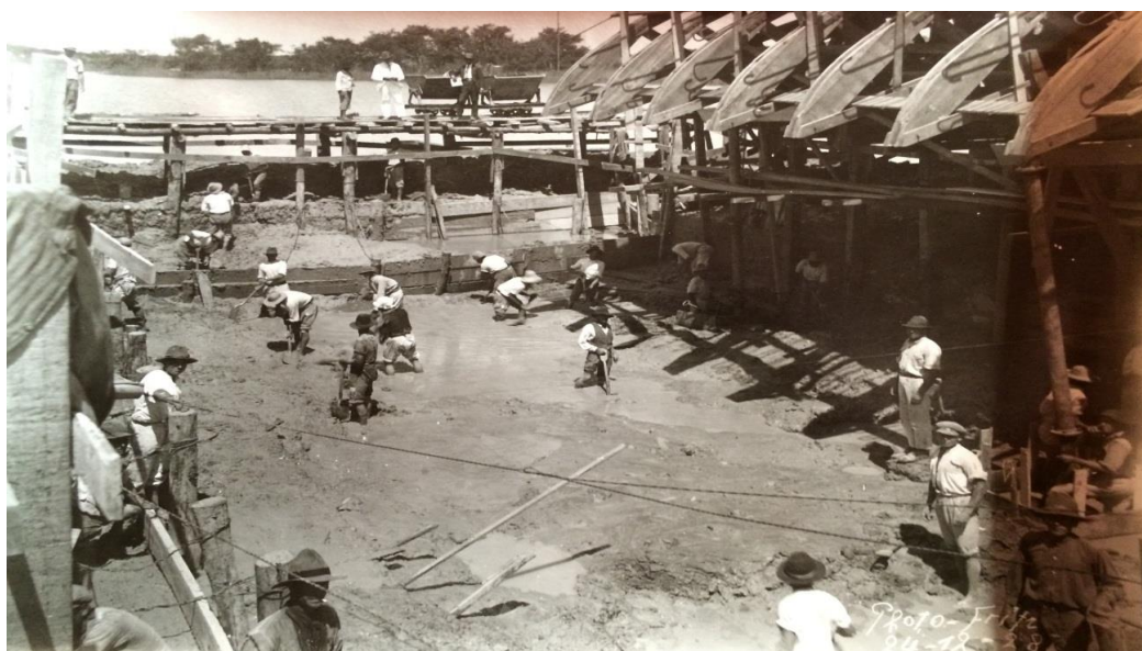
Figura 8: As obras da Ponte em andamento.
