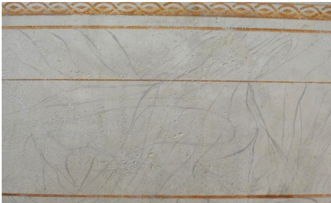
Figura 14 – Descolamento com empolamento. Corredor do prédio da antiga Escola de Belas Artes, Rua Marechal Floriano, 788, Pelotas/RS.
