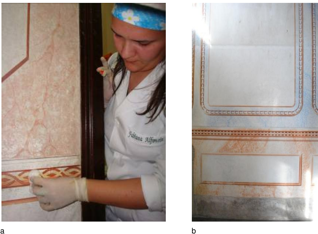
Figura 22 – (a) Higienização da superfície com algodão e água destilada antes e após consolidação. Disciplina de Conservação e Restauração de estuques, 2010; (b) Linha horizontal mostrando a diferença cromática entre a área que recebeu limpeza abrasiva com pó de pedra-pomes e a parte que não recebeu limpeza.
