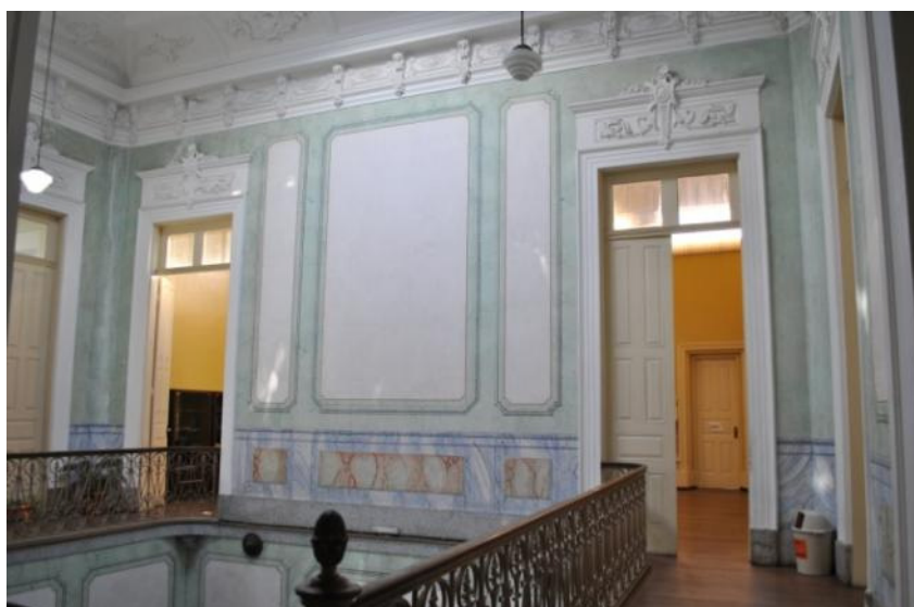
Figura 3 – Mezanino do Paço Municipal, paredes revestidas em escaiola. Praça Coronel Pedro Osório, 101, Pelotas/RS.
