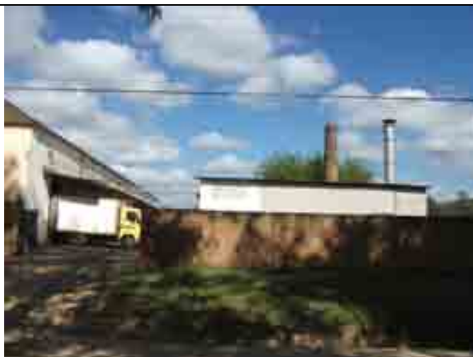
Figura 31- Chaminés da fábrica de Nestor Crochemore.
