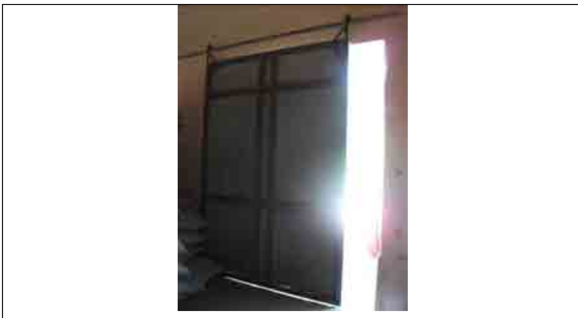
Figura 34- Portão do setor de recepção da fábrica de Nestor Crochemore.
