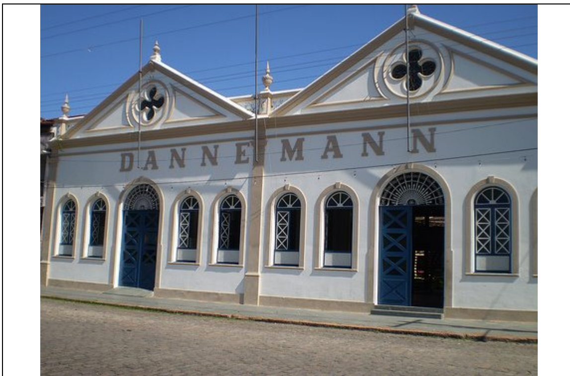
Figura 3- Fábrica Dannemann. Mais antiga fábrica de charutos do Brasil (segunda metade do século XIX), onde se notam elementos ornamentais na fachada. Localizada em São Félix, BA.
