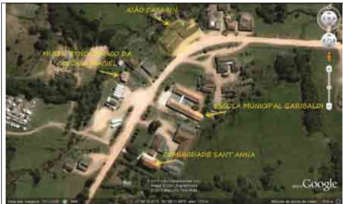
Figura 129- Localização das principais edificações do entorno da fábrica de João Casarin.
