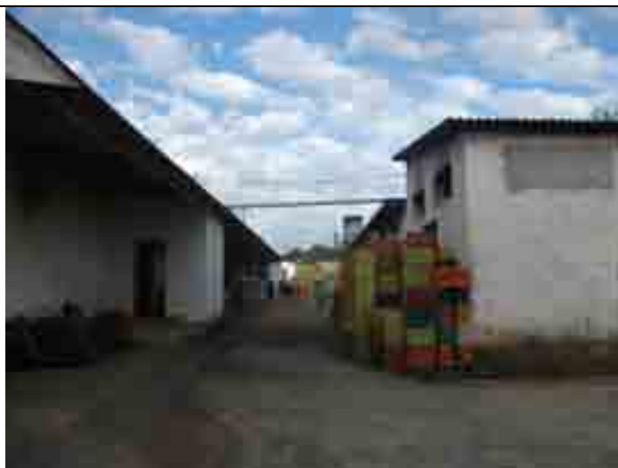
Figura 29 – Corredor entre a fábrica Nestor Crochemore e seu bloco de serviços complementares (à direita).
