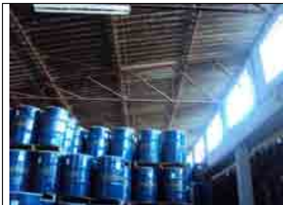
Fig. 52- Treliças metálicas da fábrica Red Indian S/A.
