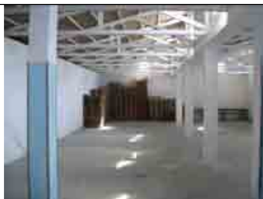
Figura 103- Tesouras de madeira da fábrica de Albino Saalfeld.
