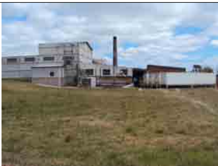
Figura 118- Chaminé da fábrica de Arthur Schiller.
