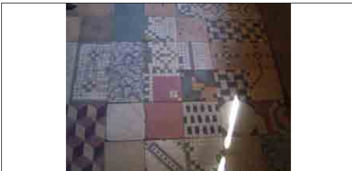
Figura 108- Imagem dos ladrilhos hidráulicos do salão de baile presente junto à fábrica de Albino Saalfeld.
