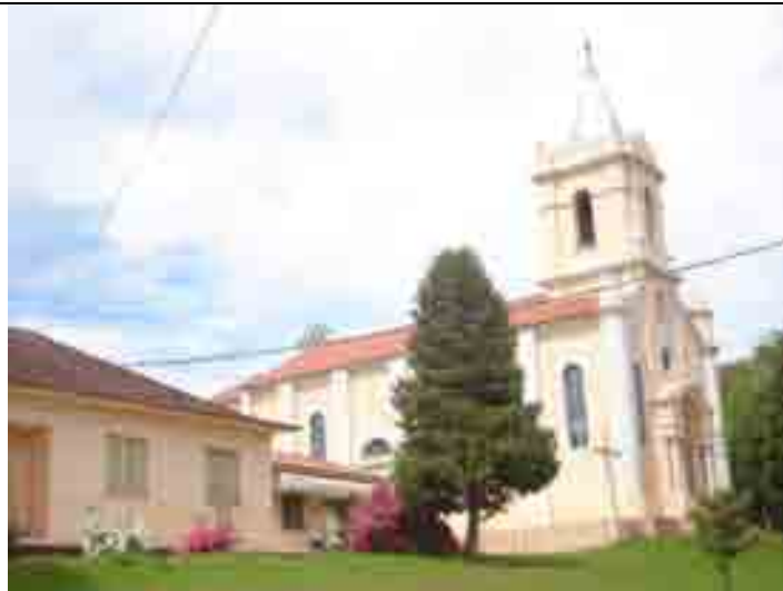
Figura 131- Igreja da comunidade Sant'Anna. Fonte: < http://www.panoramio.com/photo/15658233 >. Acesso em 20 de fevereiro de 2011.
