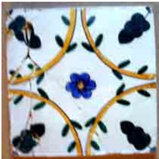
Figura 69: Exemplo de fissuras em azulejo. (Fonte: Foto tirada pela autora em 2007)
