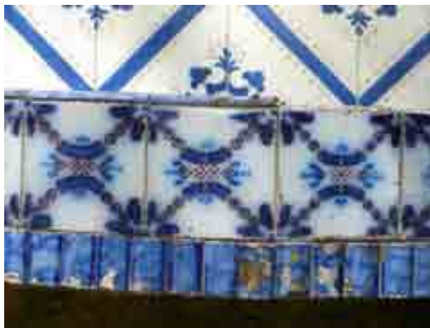
Figura 73: Exemplo de azulejo com lacunas no vidrado. (Fonte: Foto tirada pela autora em 2007)
