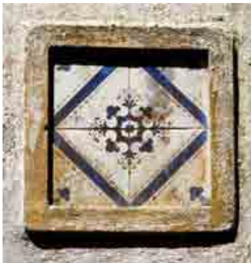
Figura 71: Exemplo de azulejo com eflorescências existente na Colônia Mazza, Pelotas/RS. (Fonte: Foto de Fernando Duran, a pedido da autora, 2008)
