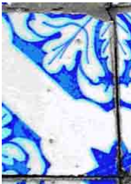
Figura 67: Exemplo de azulejo com vidrado danificado. Fonte: Foto tirada pela autora em 2007.
