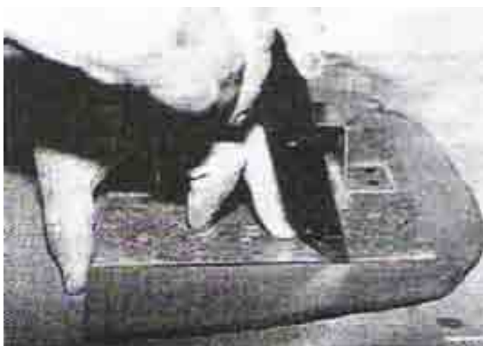
Figura 5: Corte do azulejo com faca pontiaguda. (Fonte: IEFPM, 1990)
