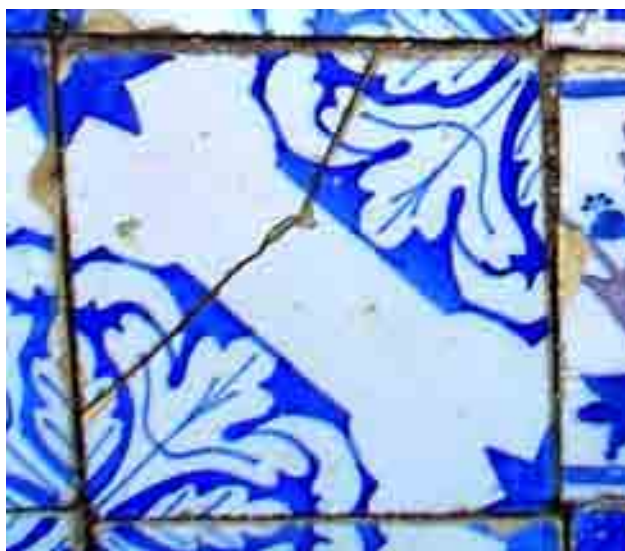
Figura 66: Exemplo de painel azulejar com azulejo fissurado. (Fonte: Foto tirada pela autora em 2007)
