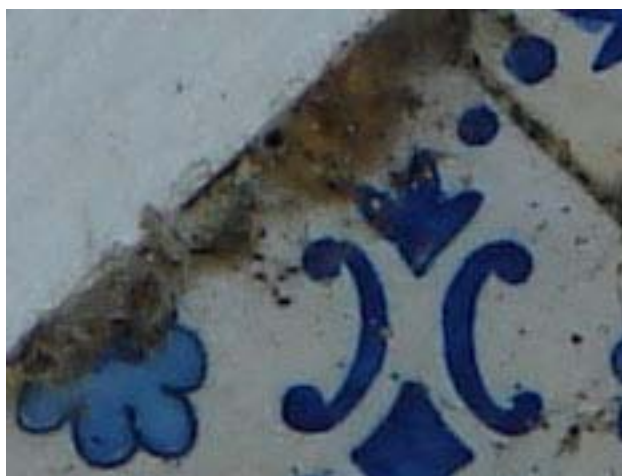
Figura 72: Exemplo de azulejo com desenvolvimento de microorganismos. (Fonte: Foto tirada pela autora em 2007)
