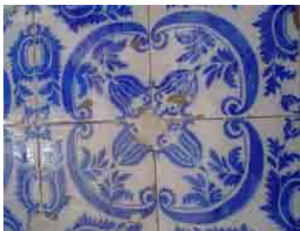
Figura 68: Exemplo de ausência em partes do azulejo. (Fonte: Foto tirada pela autora em 2007)
