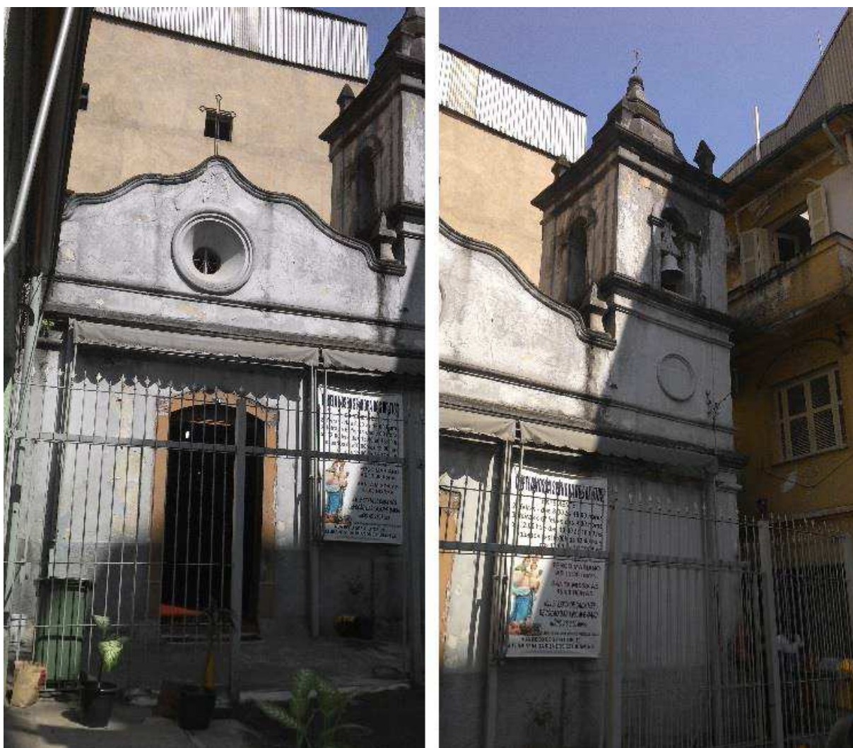
Figura 54 - Capela de Nossa Senhora dos Aflitos Fonte: Fotos da autora, 2013.
