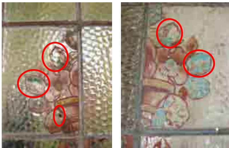
Figura 152: Detalhe do destacamento pictórico na janela JNE2 emitida (anverso) e luz refletida (reverso).
