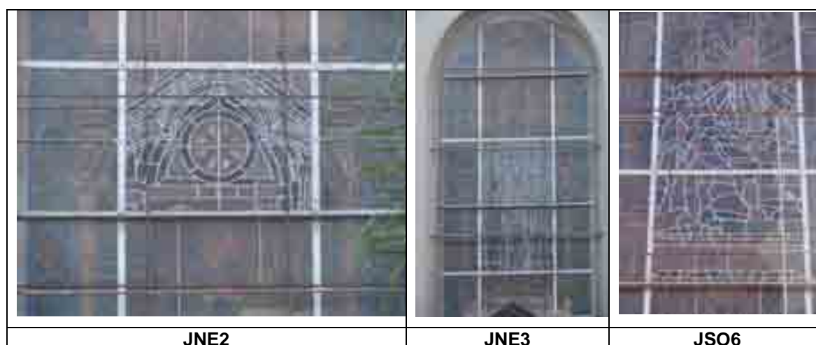
Figura 136: Exemplos de diferentes tons de calhas e soldas entre painéis. Vitrais-anverso.
