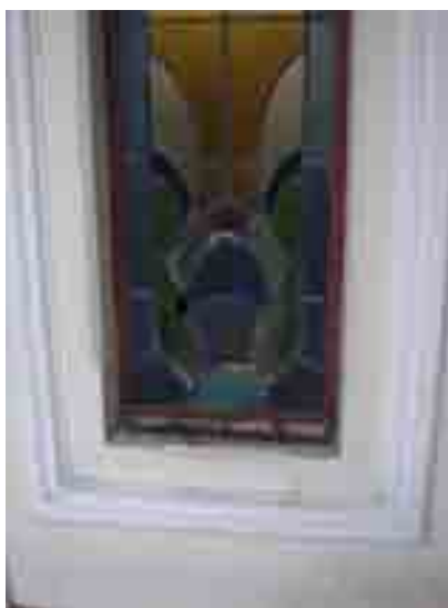
Figura 143: Detalhe do vitral JNO2- abaulamento e substituições inadequadas
