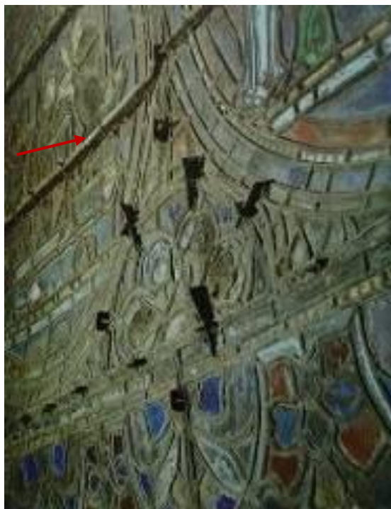
Figura 60: Barras de fixação do painel da Catedral da Cantuária, Inglaterra.
