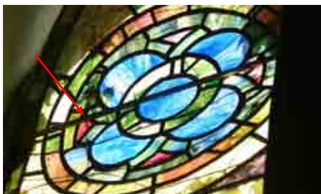
Figura 91: Detalhe da barra de fixação, janela do coro.
