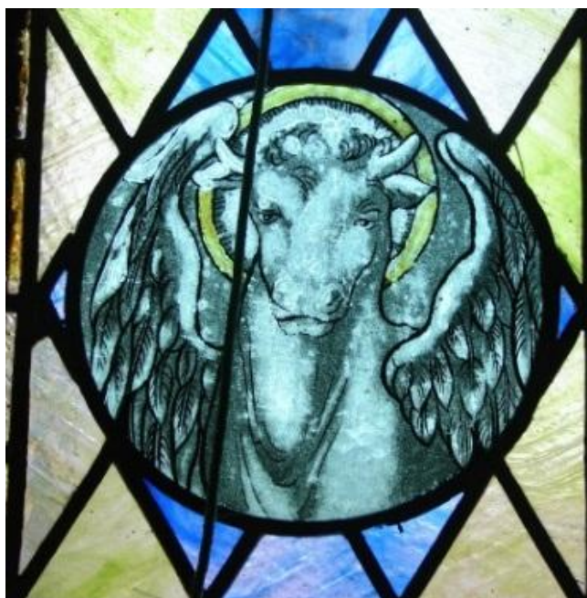
Figura 103: Detalhes de possível destacamento pictórico (JN6) - janela da sacristia.
