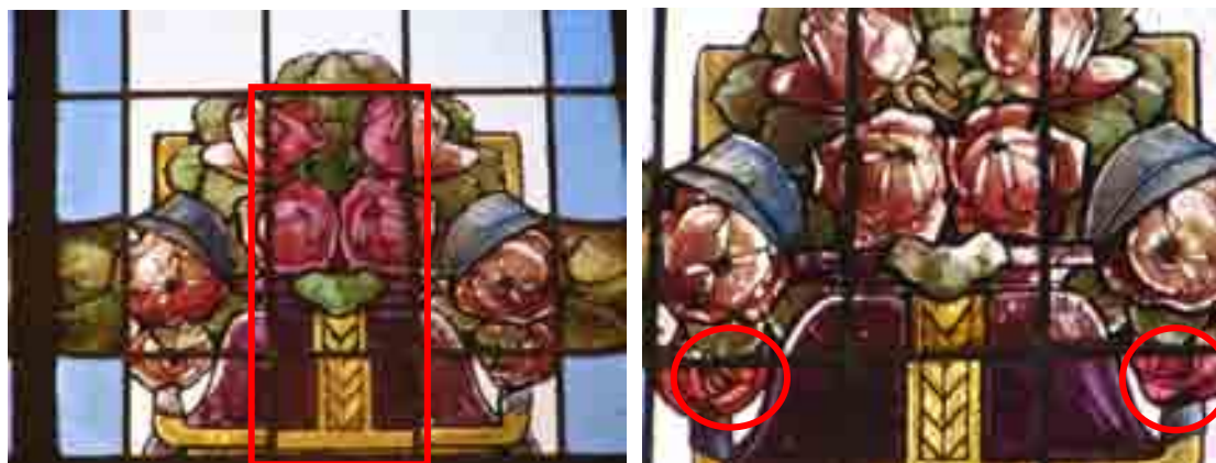
Figura 70: Diferença de coloração de fragmentos, resultado de intervenção recente: comparação da janela esquerda com a janela direita. Fonte: Autora, outubro de 2010.
