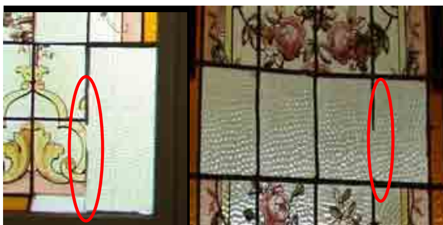
Figura 151: Intervenções inadequadas nos painéis das janelas JNE2 e JNE1- substituição de fragmentos.
