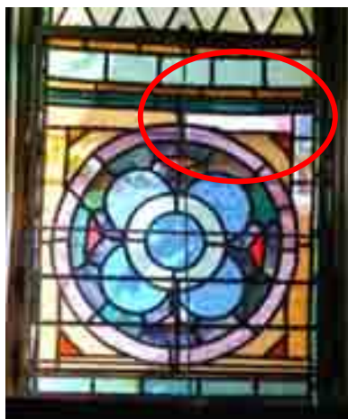
Figura 96: Vista interna da base do painel JN1 – lacuna.
