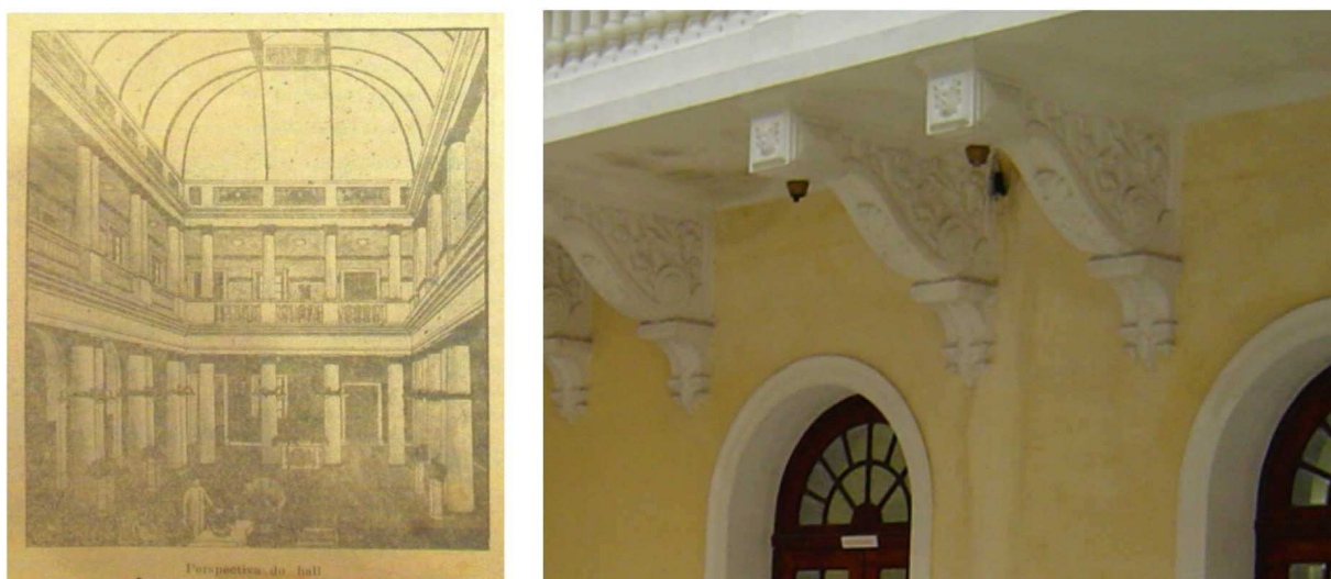
Figura 23: À esquerda (a): Perspectiva do projeto; à direita (b), “cachorros” de sustentação. Na perspectiva percebe-se que estavam projetadas colunas no térreo e no andar nobre. Na foto verifica-se detalhe da sustentação da varanda executada de fato.
