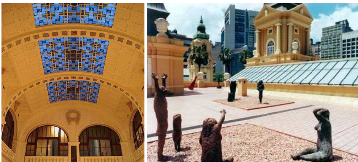
Figura 36: A cobertura de ferro e vidros do MARGS – à esquerda vista interna e à direita vista do terraço.
