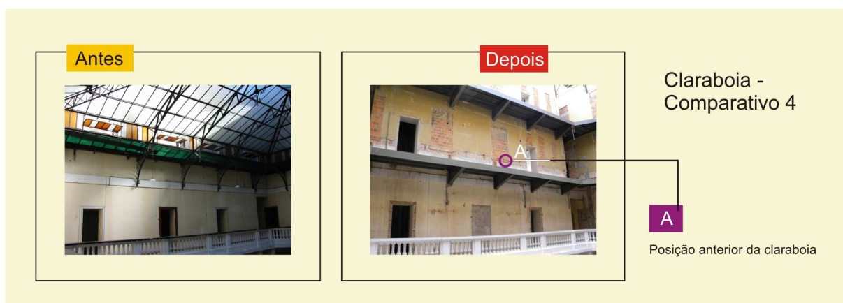
Figura 63: Onde anteriormente estava a claraboia, hoje fica a passarela de acesso as UHs do terceiro pavimento.
