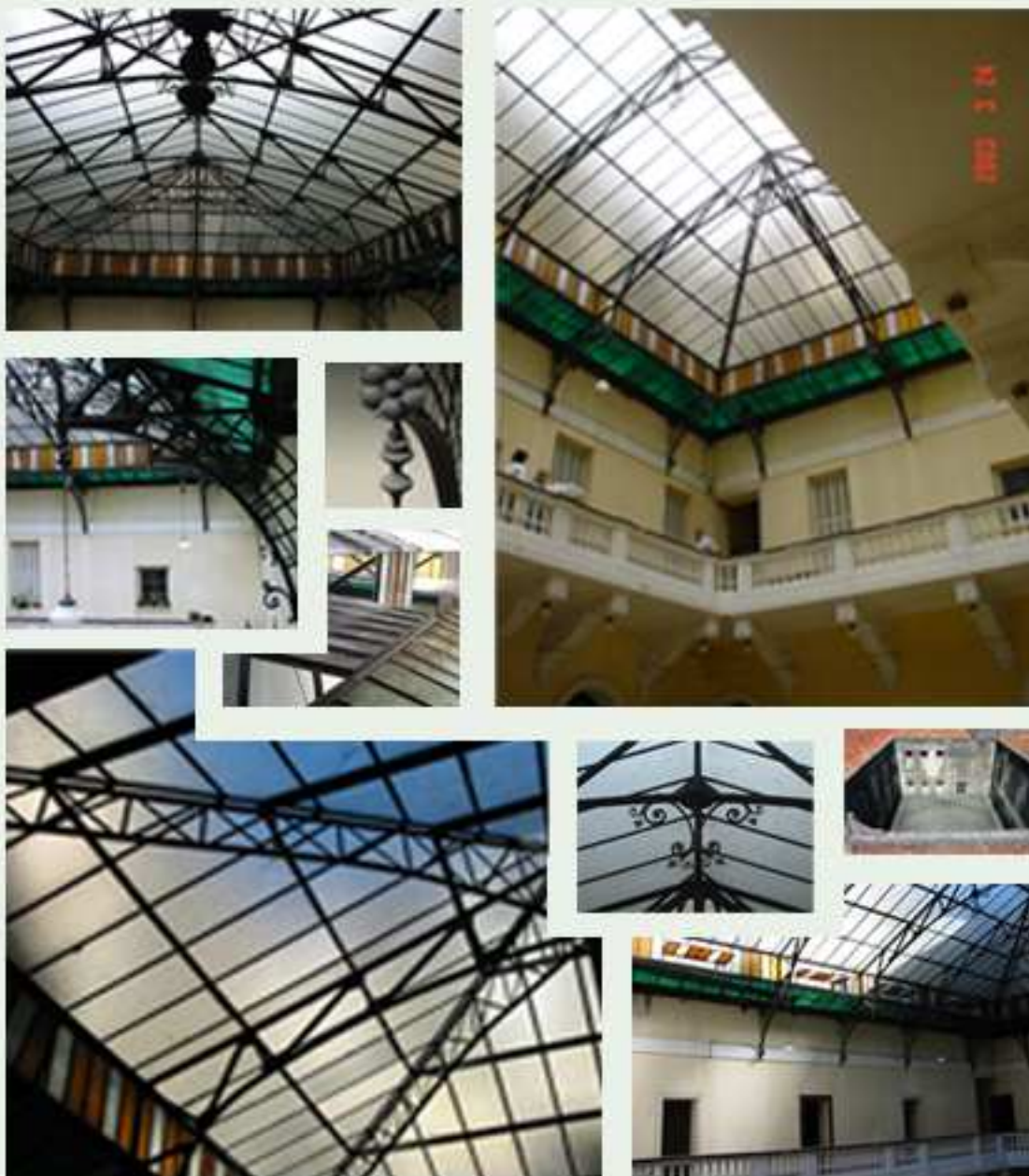
Figura 49: Grande Hotel de Pelotas. Algumas imagens do aspecto da cobertura zenital de ferro e vidros coloridos. O aspecto geral de conservação é bom: as aberturas funcionam, não há evidências de degradação - como ferrugem por exemplo, bem como não há número expressivo de vidros danificados. Imagens de 2003
