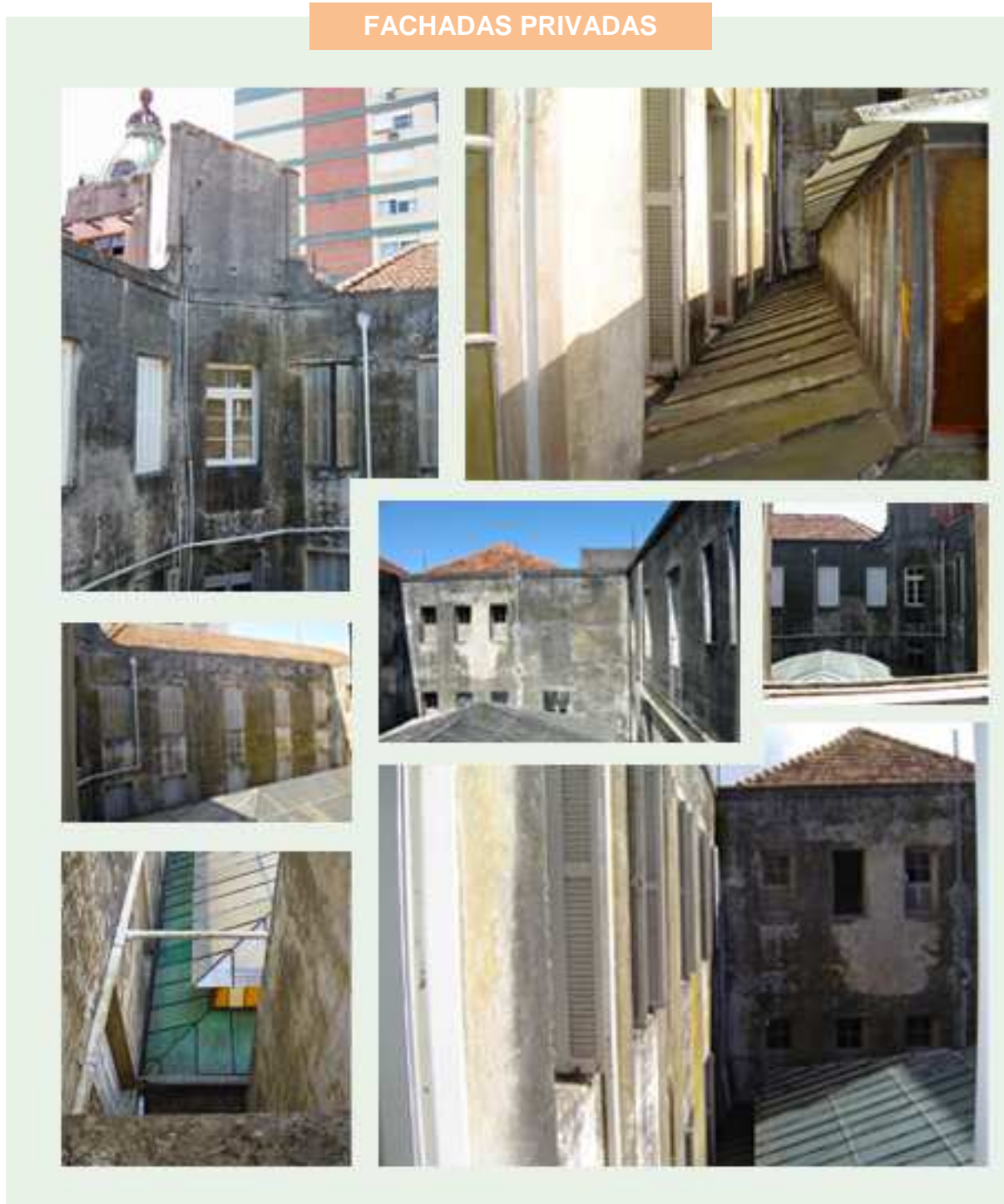
Figura 47: Grande Hotel de Pelotas. Algumas imagens do aspecto geral das fachadas privadas, apresentam patologias, lacunas, desgastes, adaptações (rede hidráulica), dentre outros danos, decorrentes da falta de manutenção. Imagens de 2003.
