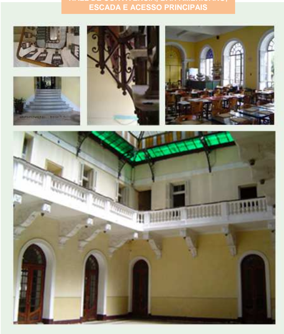
Figura 48: Grande Hotel de Pelotas. Algumas imagens do aspecto geral do grande hall de convivência coberto pela claraboia, bem como da escada de acesso principal, escada de acesso aos pavimentos superiores e bar americano. Nestes ambientes os danos são menos evidentes, provavelmente por ser a principal área social de circulação e convivência e por haver recebido alguma manutenção. Imagens de 2003.
