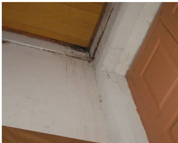
Imagem 32: Infiltração, Goteiras e Mofo
