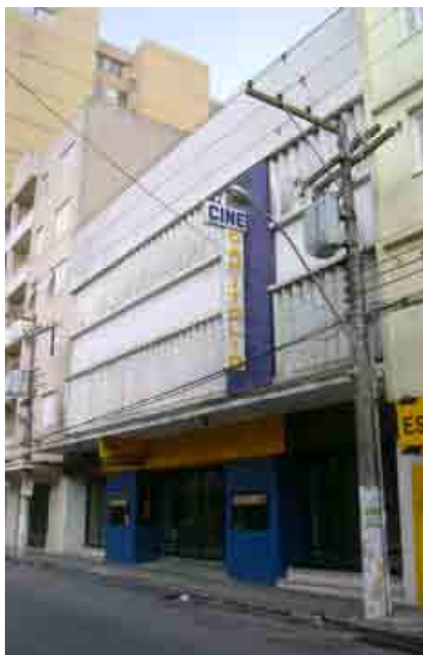
Figura 39 – Fachada do Cine Capitólio, após a reforma e funcionando como estacionamento. Fotografia da autora.
