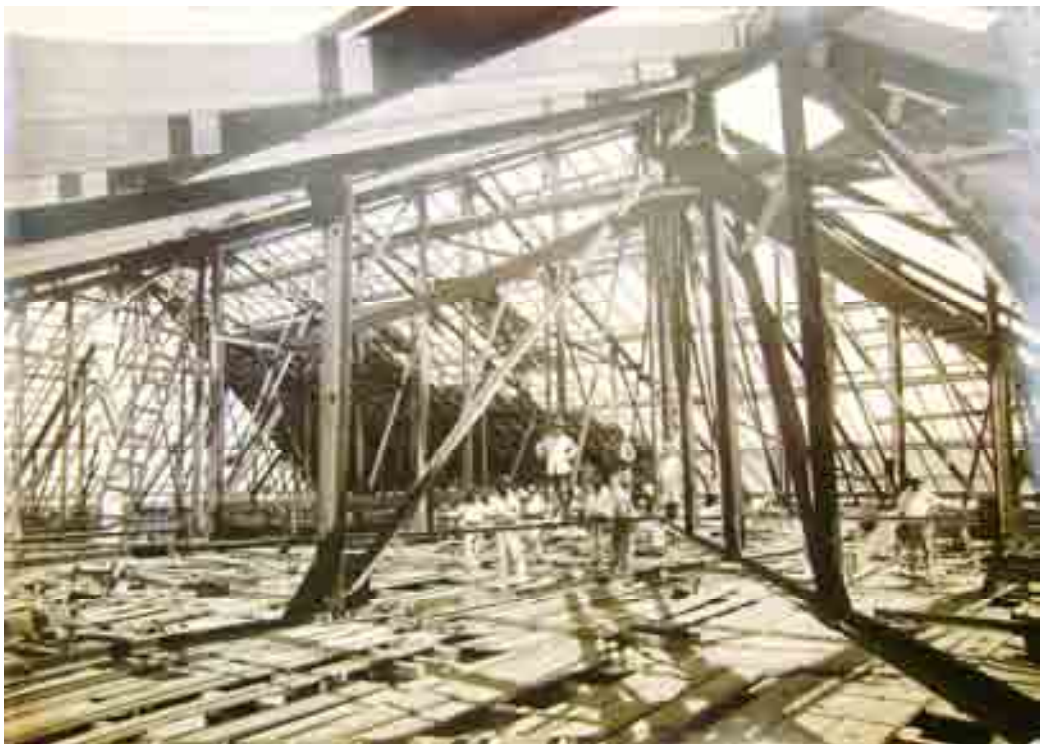
Figura 15 – Telhado do Theatro Guarany. Fonte: Acervo da Bibliotheca Pública Pelotense.
