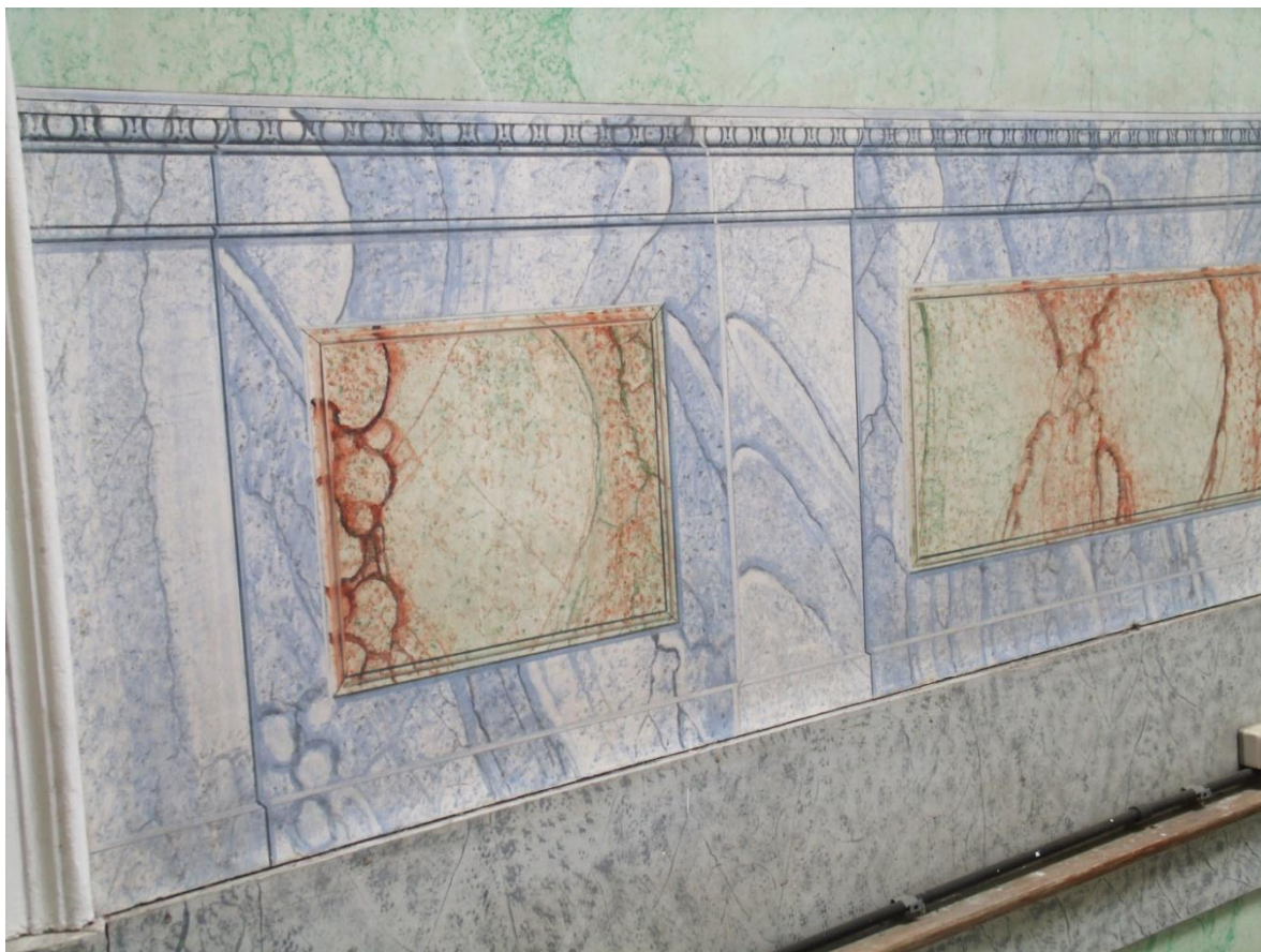
Figura 24: Efeitos de trompe l'oeil nas escaiolas do patamar da escada da Prefeitura de Pelotas.
