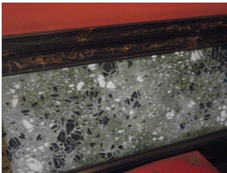
Figura 29: Detalhe de marmoreado que imita o granito, em parede do Palácio de Nova Friburgo, no Rio de Janeiro.
