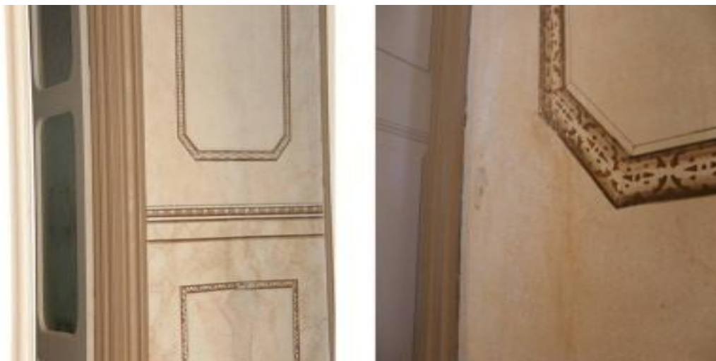
Figura 46: Aspectos das escaiolas do pequeno hall da escada.
