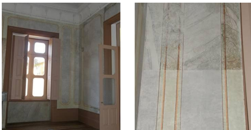
Figura 49: Detalhes das escaiolas que revestem as paredes da sala de jantar.
