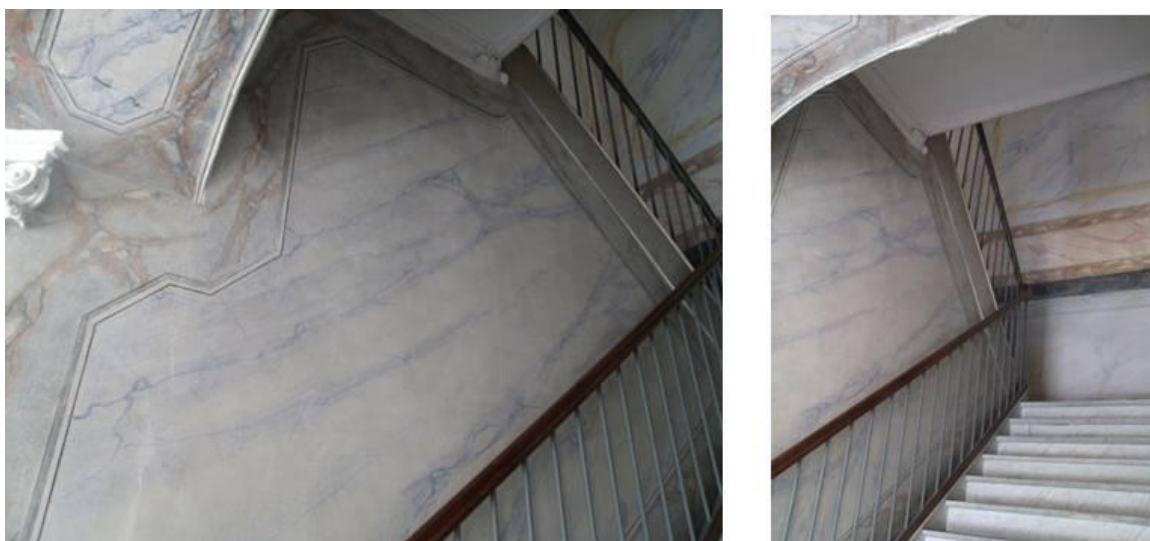
Figura 60: Aspectos das paredes escaioladas do primeiro lance da escada.
