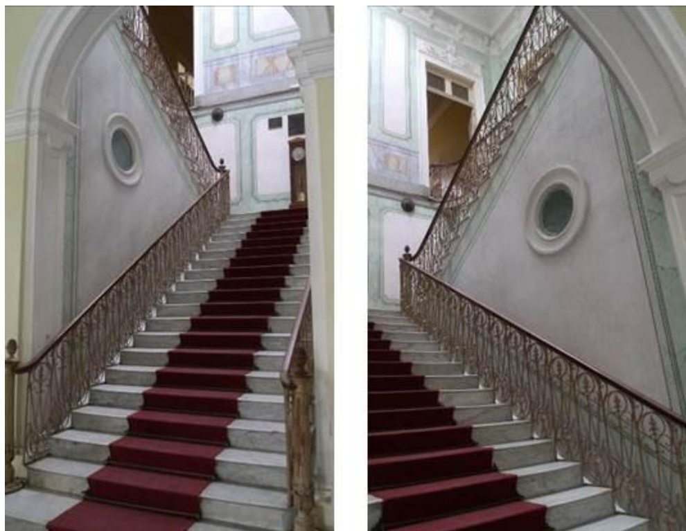
Figura 122: Detalhes do primeiro lance da escada.
