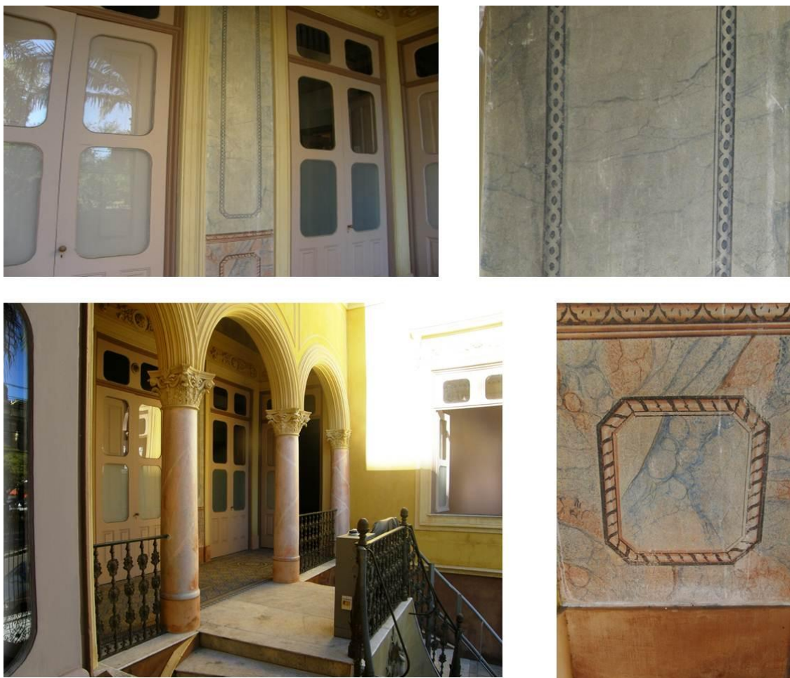
Figura 42: Aspectos das escaiolas da varanda de acesso ao casarão.
