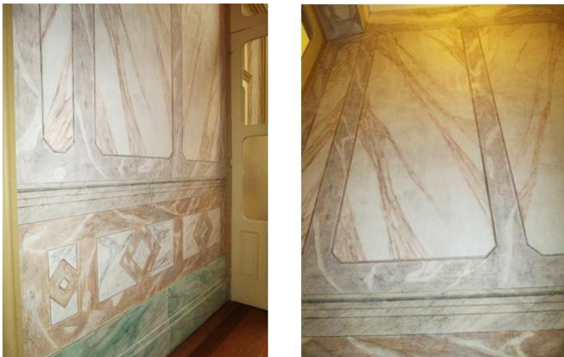
Figura 36: Imagem do corredor para a área íntima.
