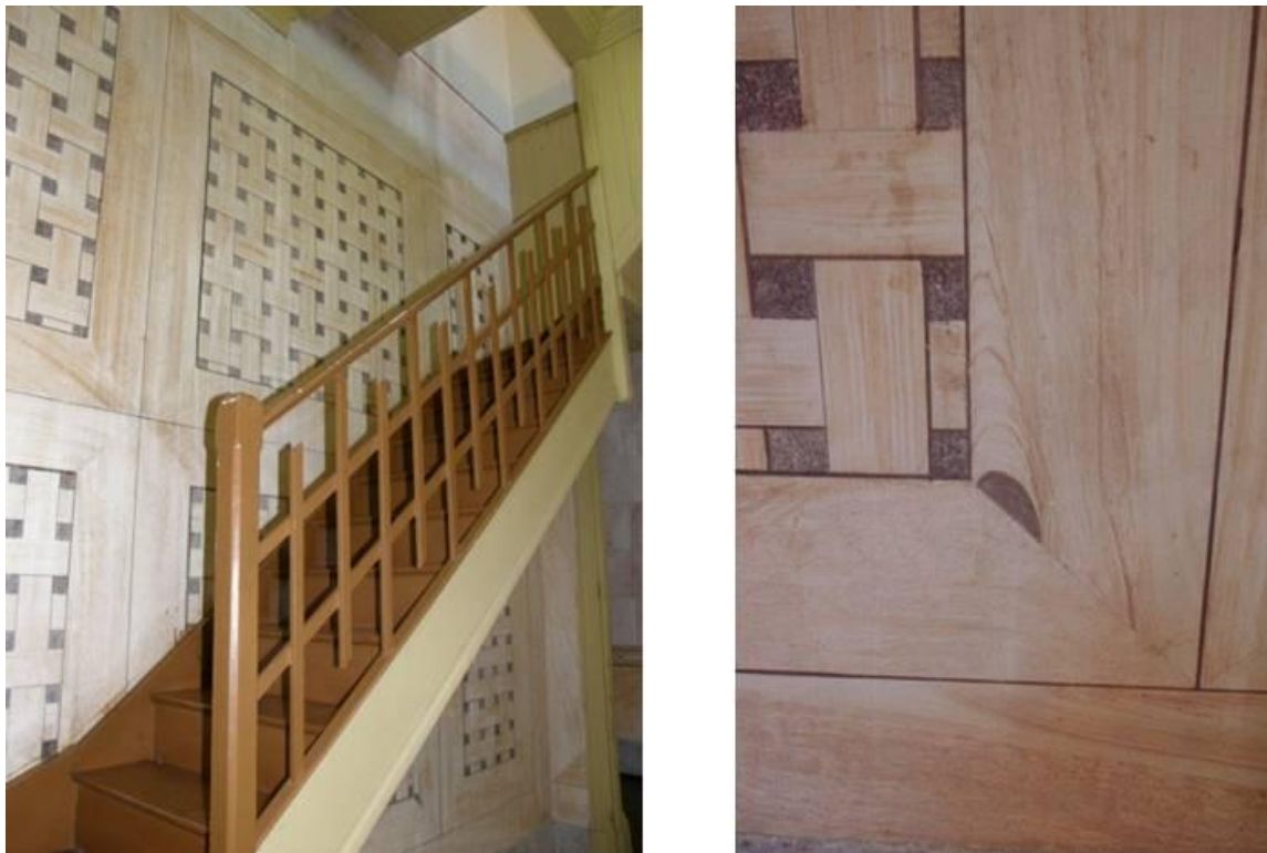
Figura 70: Aspectos da sala da escada que leva ao segundo pavimento da construção.
