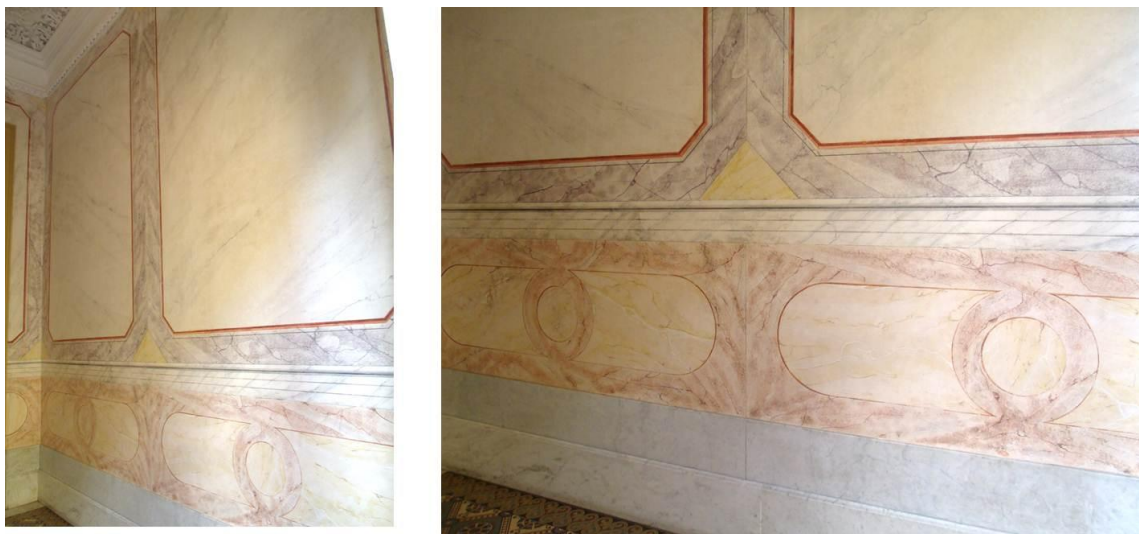
Figura 34: Imagens do hall de entrada do casarão.
