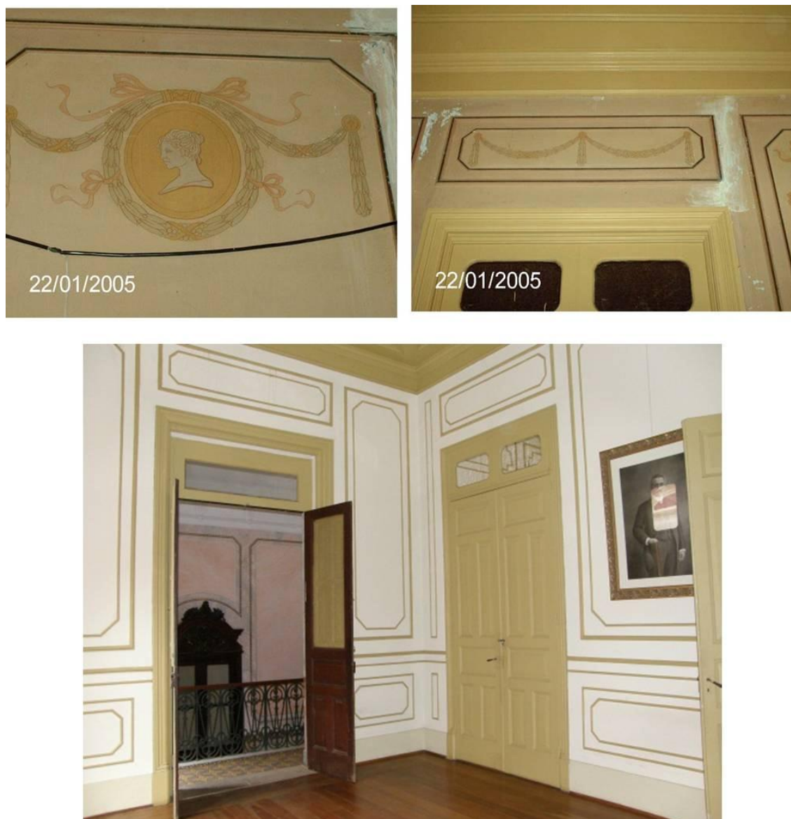
Figura 72: Nas duas imagens acima: As pinturas decorativas de uma sala da residência, suprimidas no processo de restauro. Na imagem abaixo: Aspecto do ambiente após a restauração.
