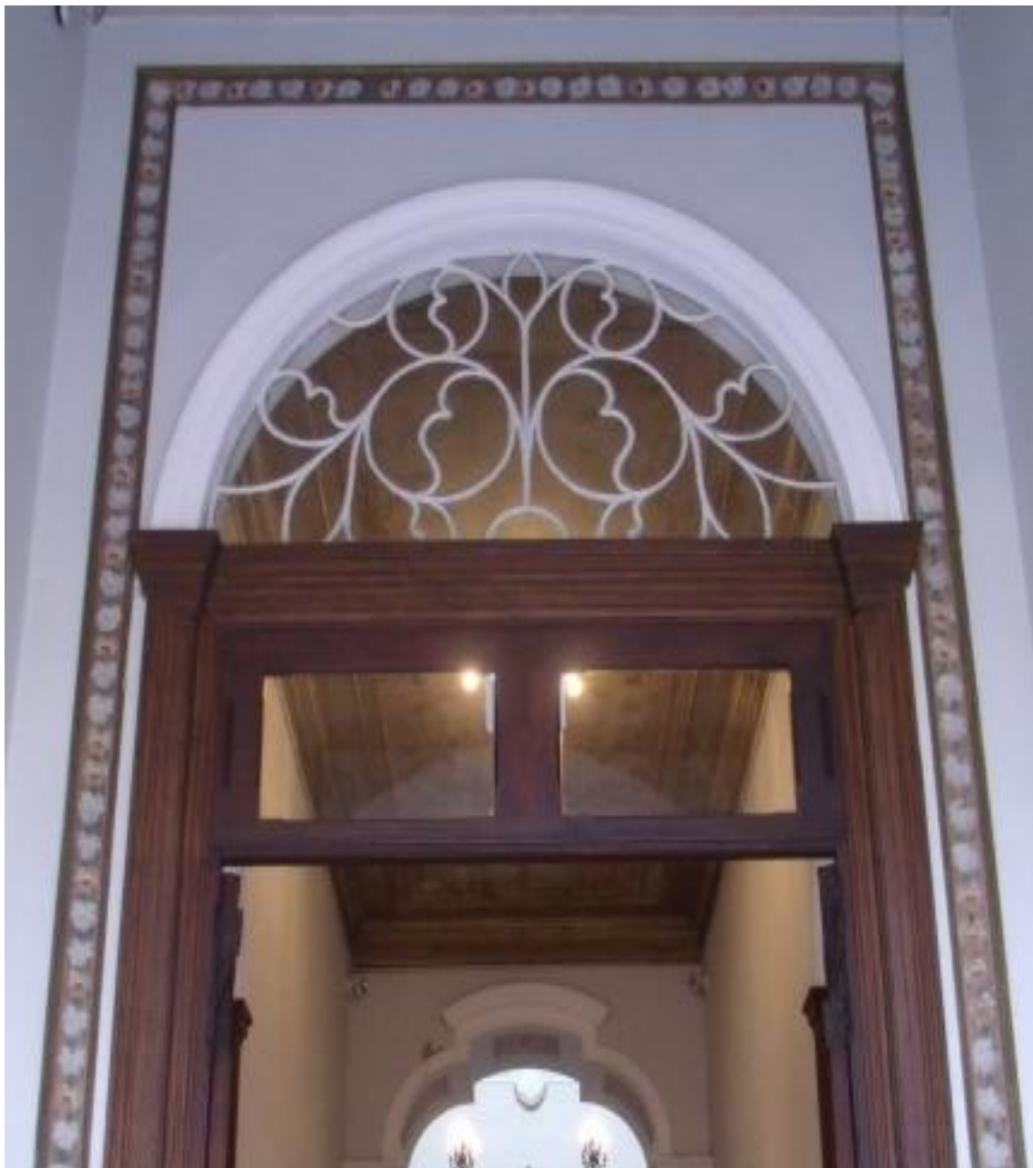
Figura 95: Detalhe do friso que circunda a porta de entrada, pintado a mão livre sobre a parede.
