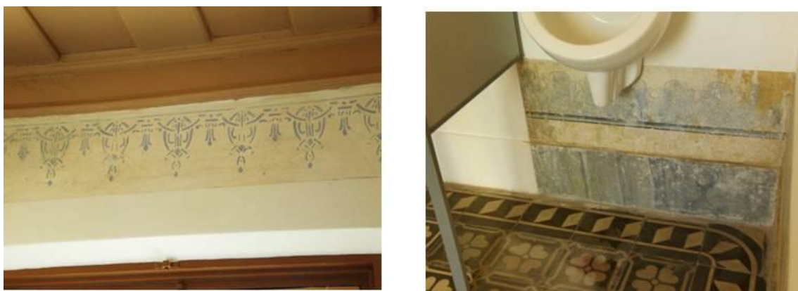
Figura 53: Detalhes do banheiro do pavimento térreo, situado ao fundo do corredor à esquerda.
