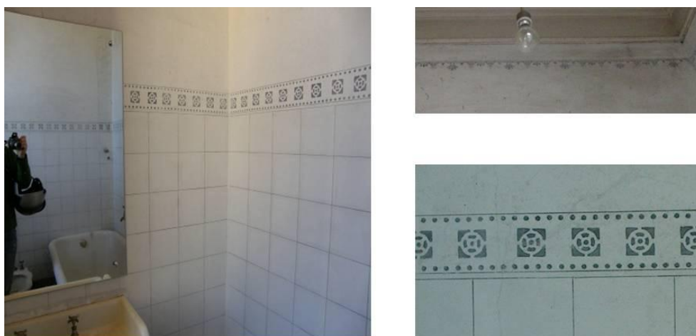
Figura 51: Detalhes do banheiro do andar superior.
