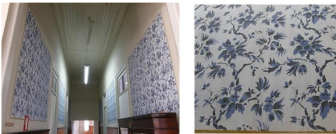
Figura 90: Aspecto do corredor e detalhe da decoração em estêncil.
