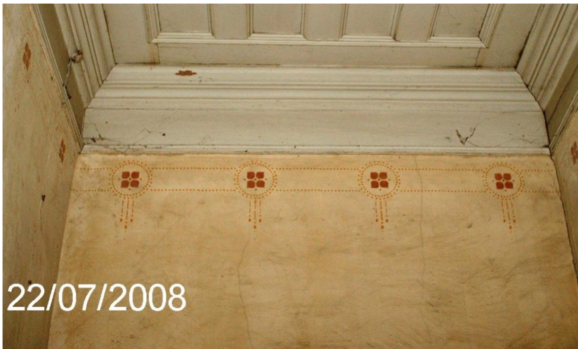
Figura 55: Detalhe da decoração original da escada de acesso ao segundo piso.
