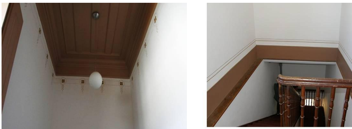
Figura 54: Aspecto da decoração da escada de acesso ao segundo piso, após o restauro.
