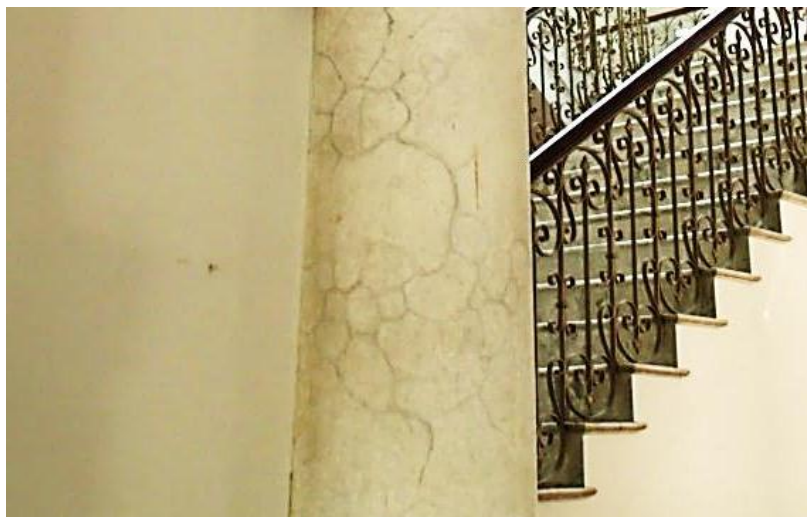
Figura 96: Detalhe do fuste de uma coluna decorado com escaiola, no pavimento térreo.
