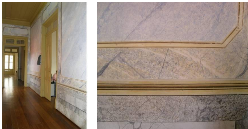
Figura 67: Aspectos do primeiro corredor e das decorações em escaiola.
