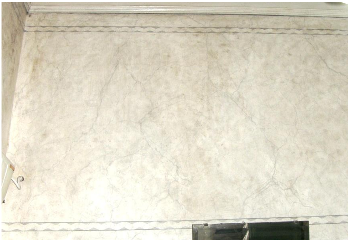
Figura 75: Aspecto da parede do banheiro revestida com escaiola.
