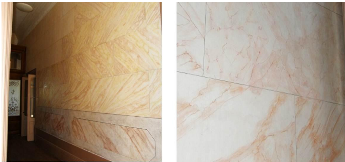
Figura 43: Aspectos do corredor, do lado direito do corpo da residência.
