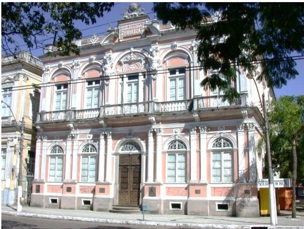
Figura 91: Imagem da fachada da Biblioteca Pública Pelotense.
