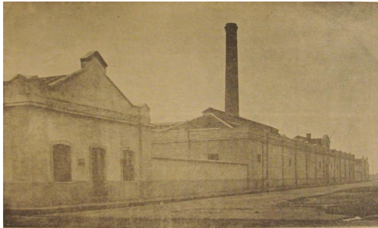
Figura 180 - Chaminé da fábrica Fiação e Tecidos Pelotense situada junto à casa das máquinas possui 36 e \frac{1}{2} metros ou 120 pés de altura, dotada interna e externamente de escadas que facilitavam a limpeza. Próximo à fábrica localizava-se a oficina de reparação, que destacava-se pelo maior e mais completo arsenal de ferragens de Pelotas. (Almanach de Pelotas. 1916, p.252 )
