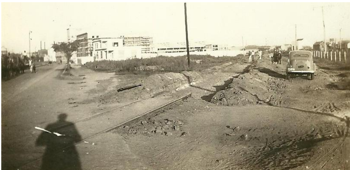
Figura 18: Escavações efetuadas no trecho que recebera posteriormente os trilhos. Fonte: Acervo Associação Comercial de Pelotas. Nº de inventário: MACP0212
