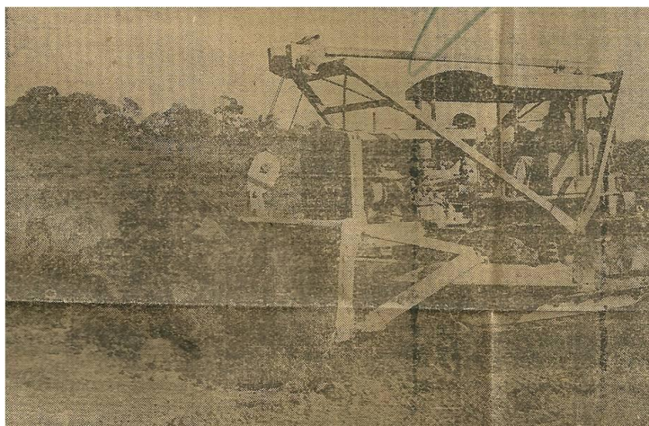
Figura 04: Reprodução da fotografia veiculada no Jornal Diário Popular de 28/05/1948. Legenda original: “Um “equipo” de máquinas, trabalhando além de Canguçu, preparando o leito para a futura colocação dos trilhos.” Fonte: Jornal Diário Popular 28/05/1948
