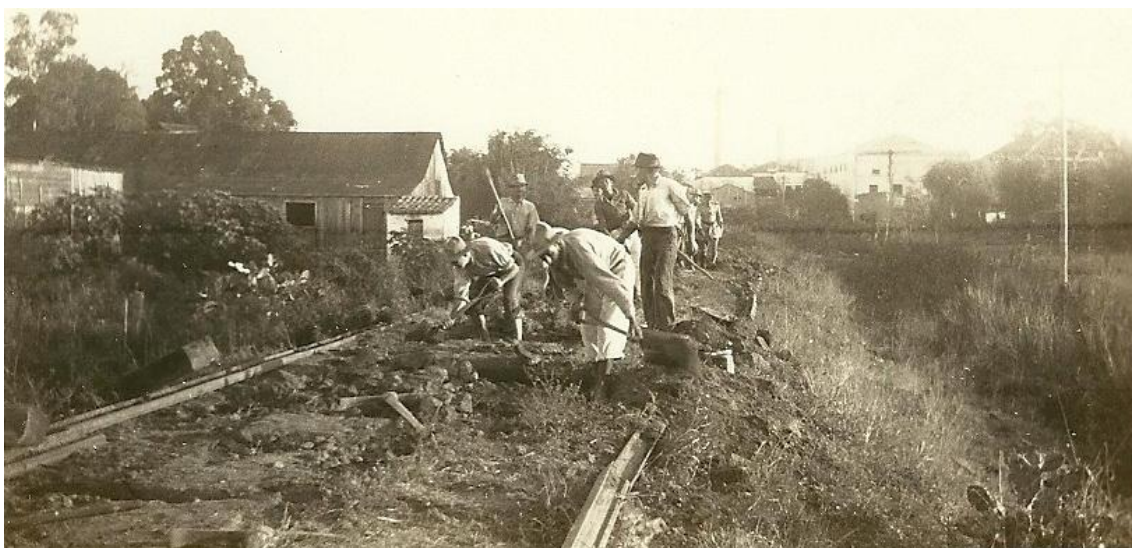
Figura 20: Preparação do terreno que recebera posteriormente os trilhos.
