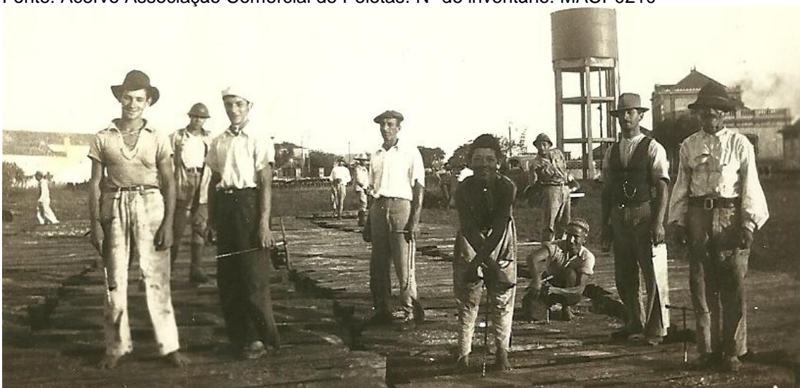
Figura 17: Trabalhadores preparando os dormentes para colocação dos trilhos.
