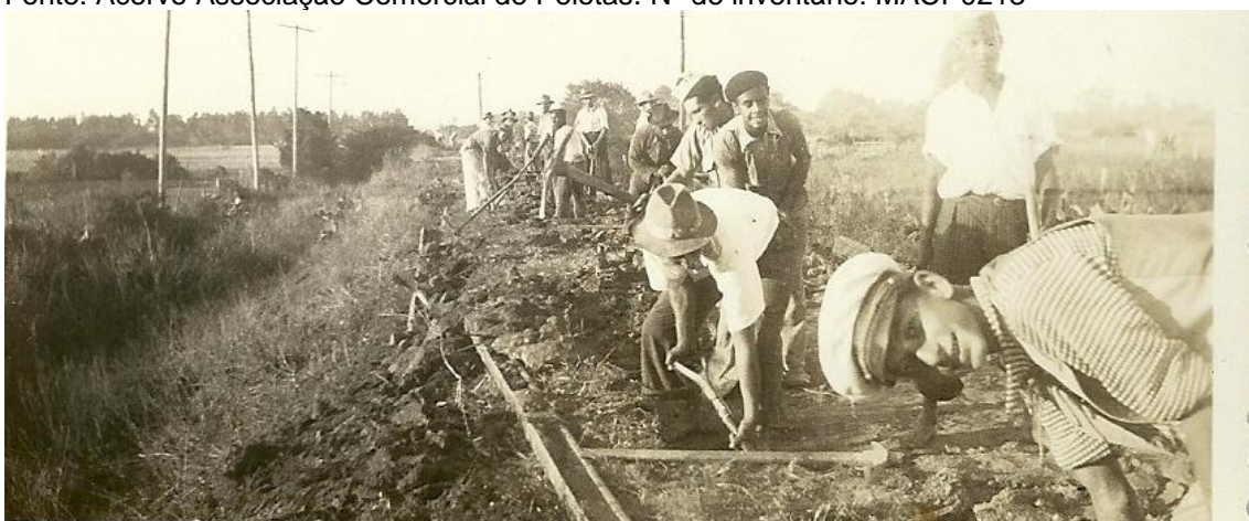
Figura 21: Trabalhadores atuando na preparação do terreno para recebimento dos trilhos.
