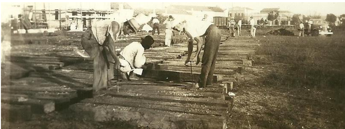
Figura 16: Preparação dos dormentes a serem colocados na estrada de ferro Pelotas-Santa Maria. A preparação da madeira acontecia na zona urbana de Pelotas.
