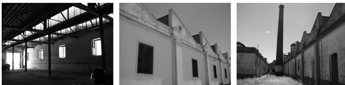
Figura 25: Interior e exterior do prédio onde funcionou a fábrica de tecidos. Estrutura de ferro da cobertura e iluminação zenital (1), aspecto externo dos sheds (2) e o pátio interno da fábrica com a chaminé. Fonte: Acervo da autora, 2007.
