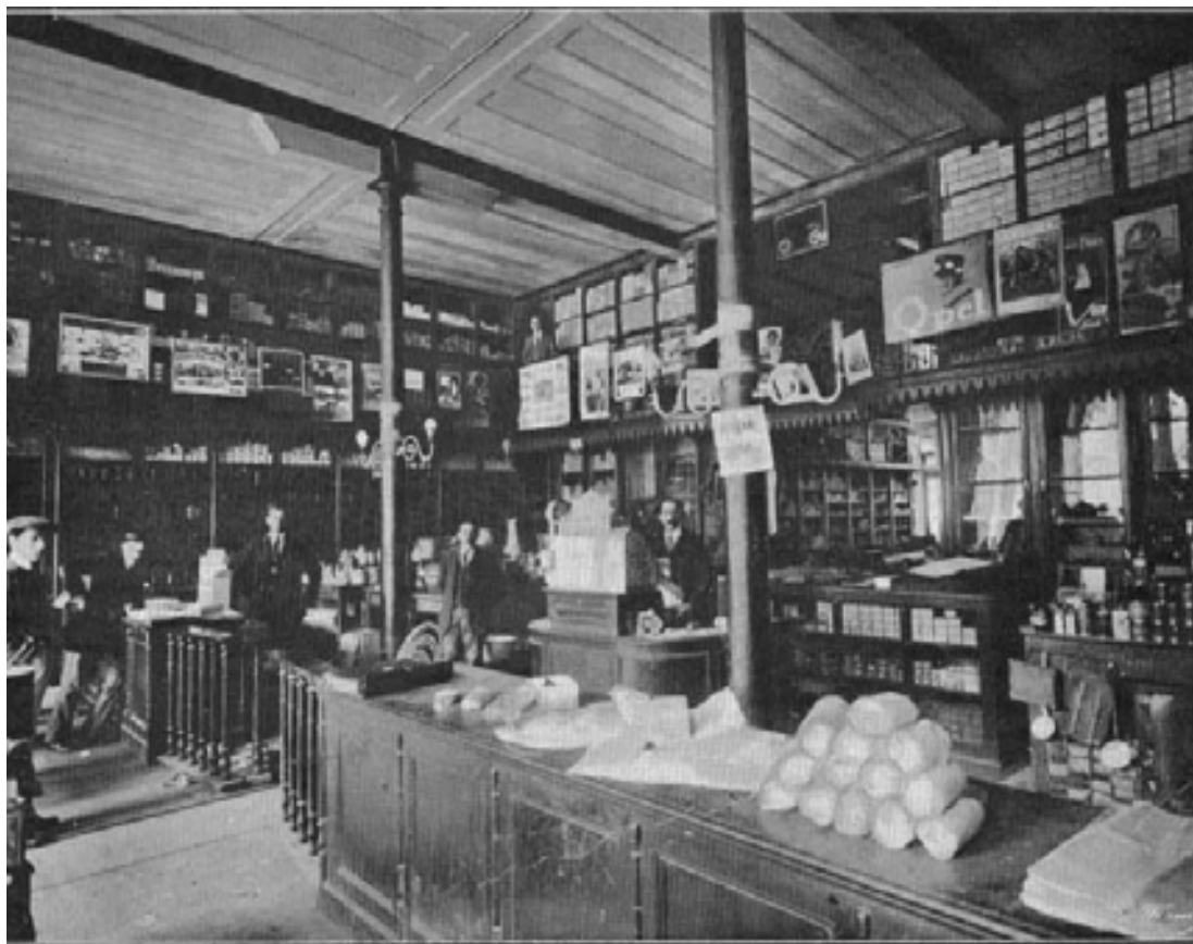
Figura 64: Interior da Ferragem Behrendsdorf situada à rua Quinze de Novembro. Observam-se colunas em ferro fundido próximas ao balcão de atendimento da loja.
