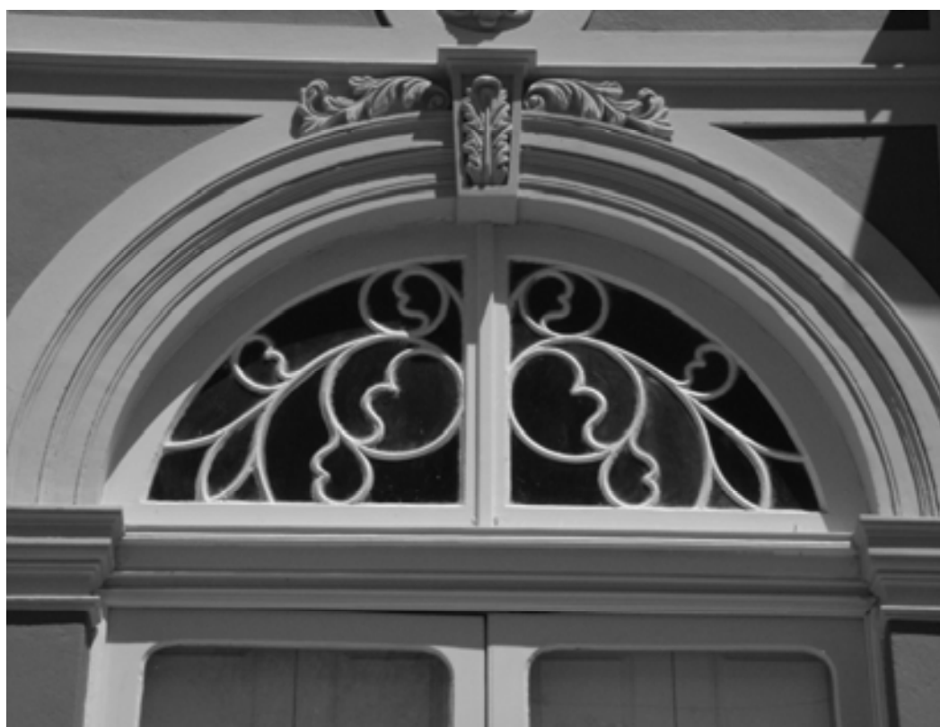
Figura 187: Elemento compositivo de união – elo isolado em bandeira em arco pleno bipartida. Tipologia bandeira.
