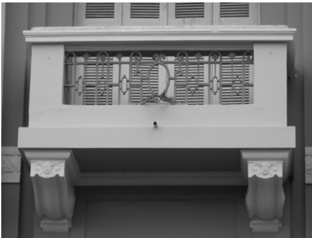
Figura 154: Aspecto estrutural. Técnica. Balcão misto reto.
