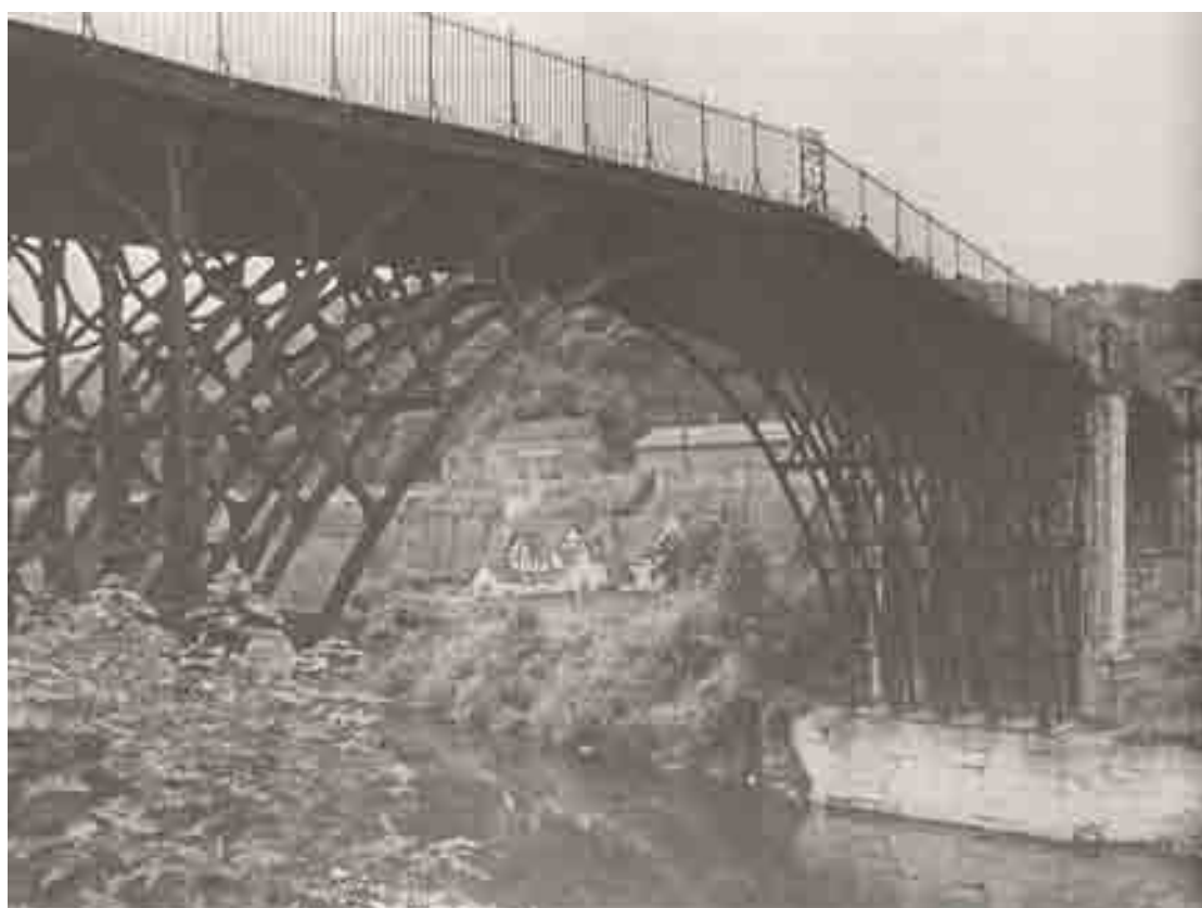
Figura 7: Primeira ponte de ferro do mundo. Coalbrookdale, em Shropshire, Inglaterra (1779). Atravessa o Severn vencendo um vão de 30m.
