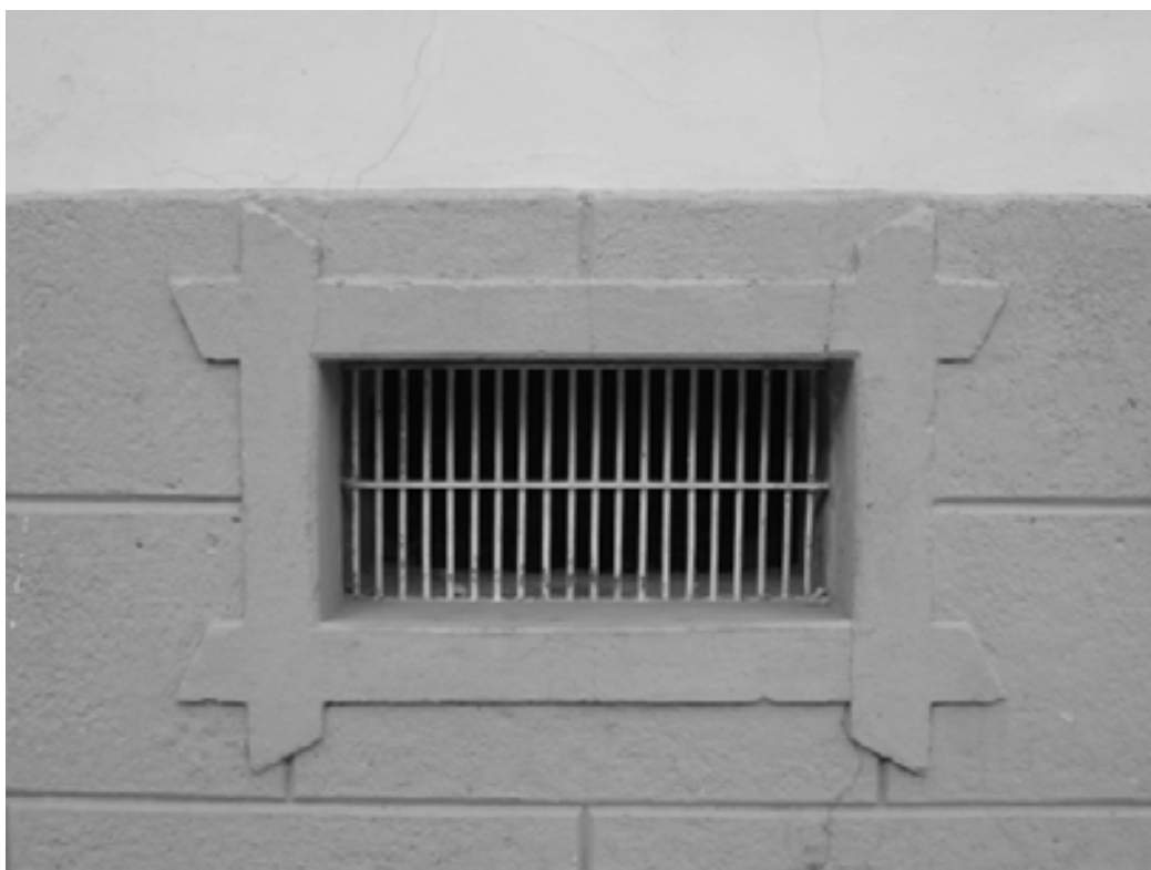
Figura 198: Técnica. Tipo de grade em janela de porão retangular em barras de seção circular.
