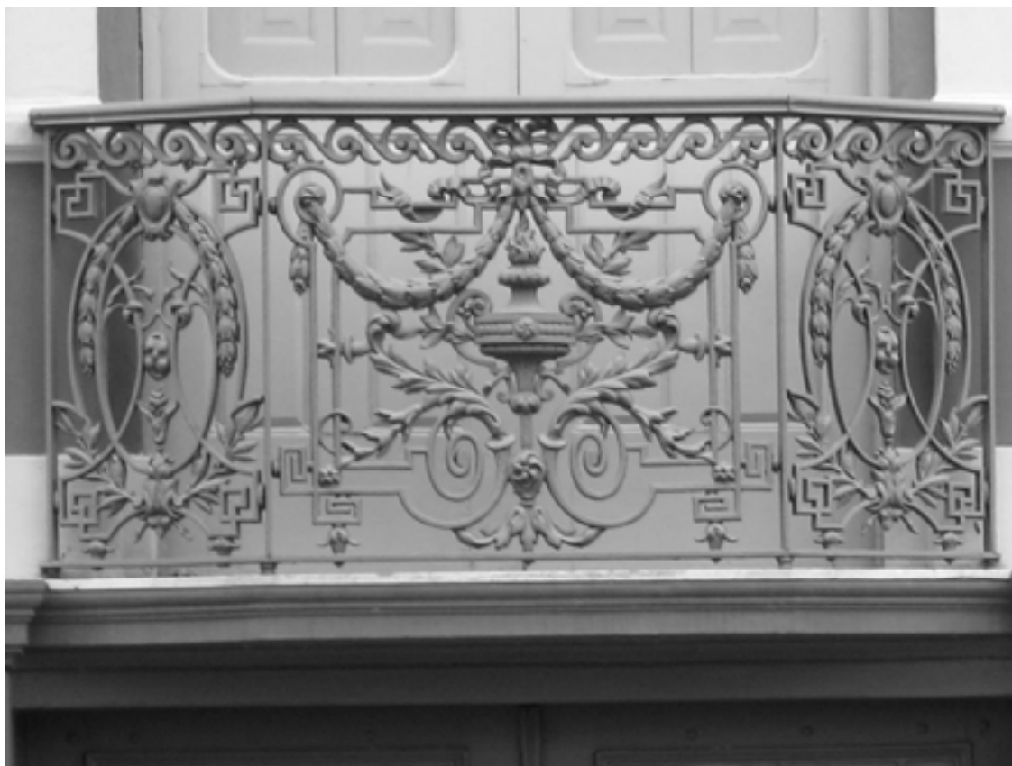
Figura 115: Balcão confeccionado com predomínio da técnica de fundição.
