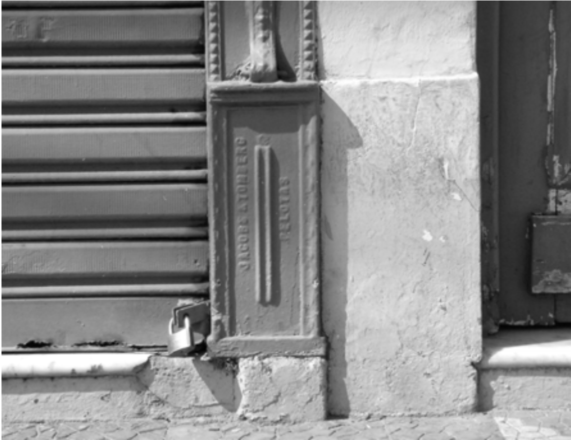
Figura 46: Montante de cortina metálica com inscrição “Jacobs & Tomberg” na base.
