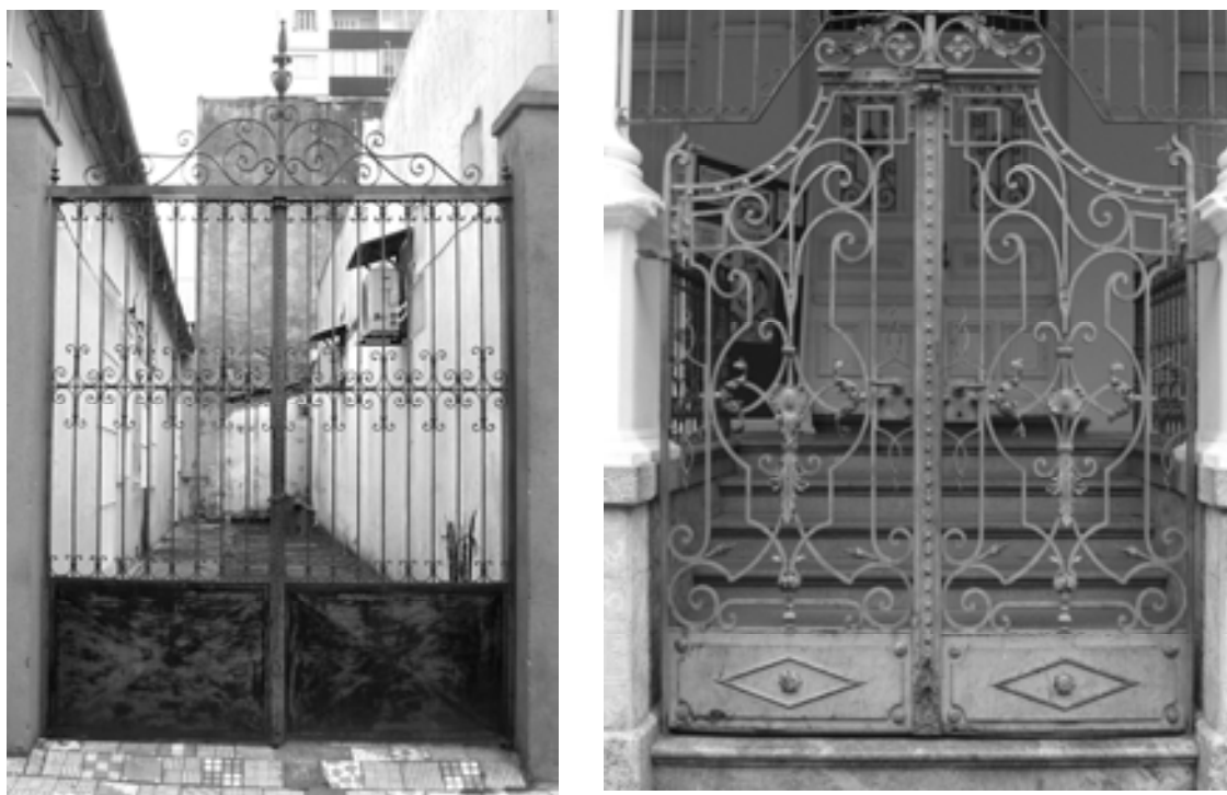
Figura 104: Diferenças técnico-construtivas e formais entre portões do primeiro e segundo períodos ecléticos. O primeiro de edificação residencial e o segundo do Clube Caixeiral.
