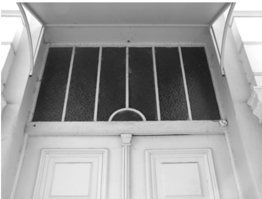
Figura 177: Técnica. Estrutura com perfil “T”. Tipologia bandeira.
