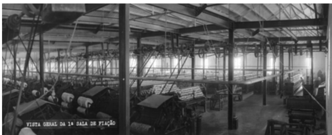
Figura 45: Interior de uma sala da Fiação. Pilares, vigas “I” e estrutura da cobertura.
