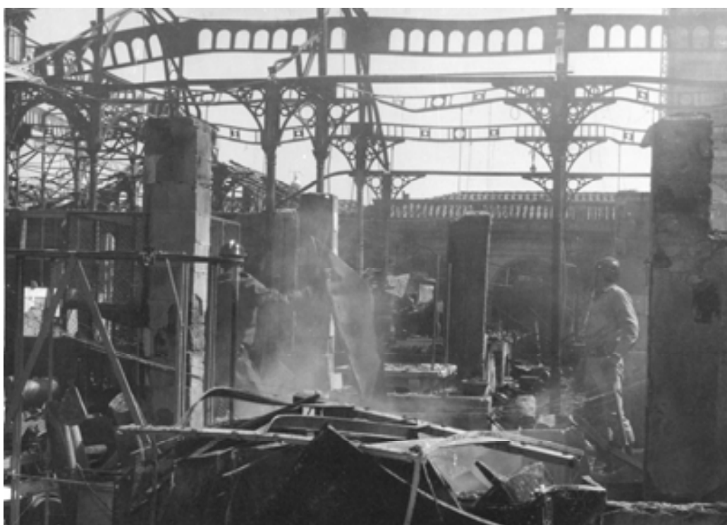
Figura 38: Estrutura metálica do Mercado Central logo após o incêndio.
