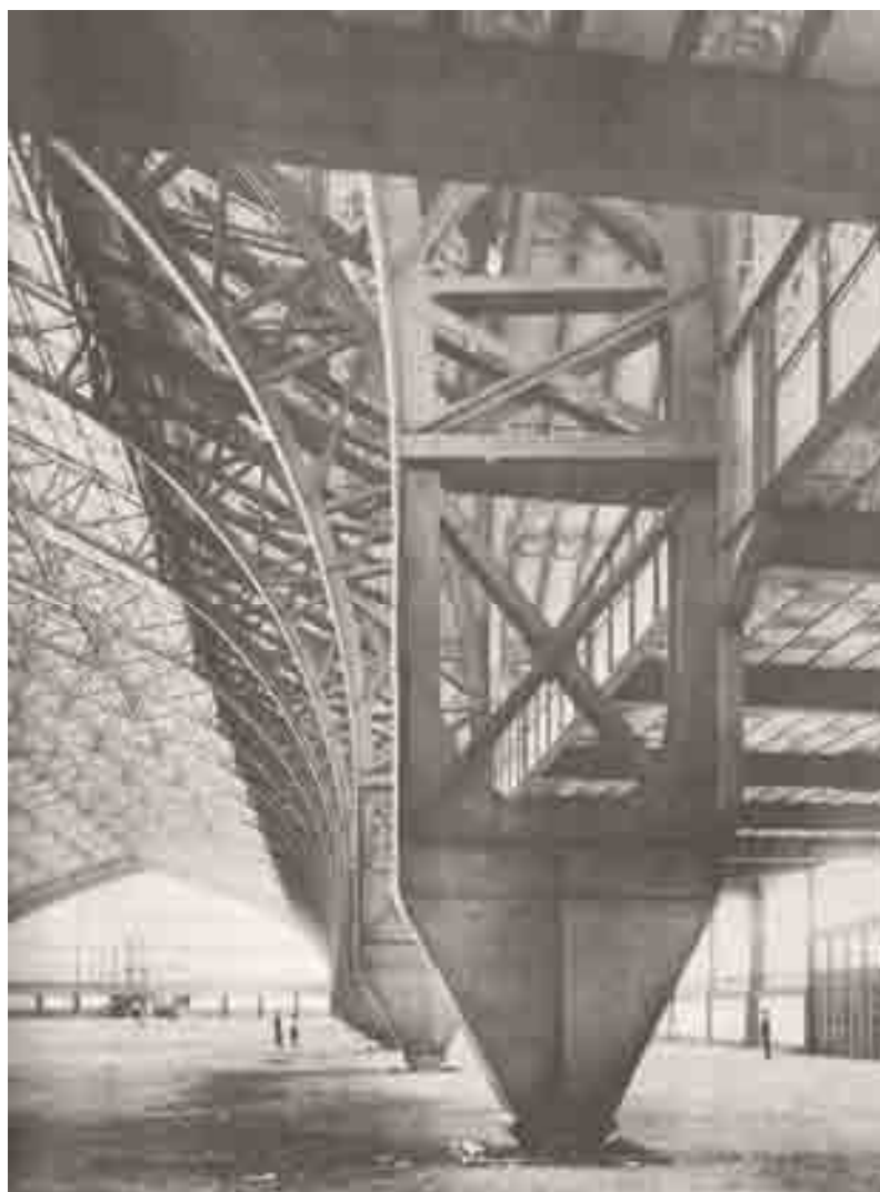
Figura 19: Armações curvas com apoio direto no solo. Galerie de Machines da Exposição de 1889 em Paris, de Charles Dutert e Victor Contamin.
