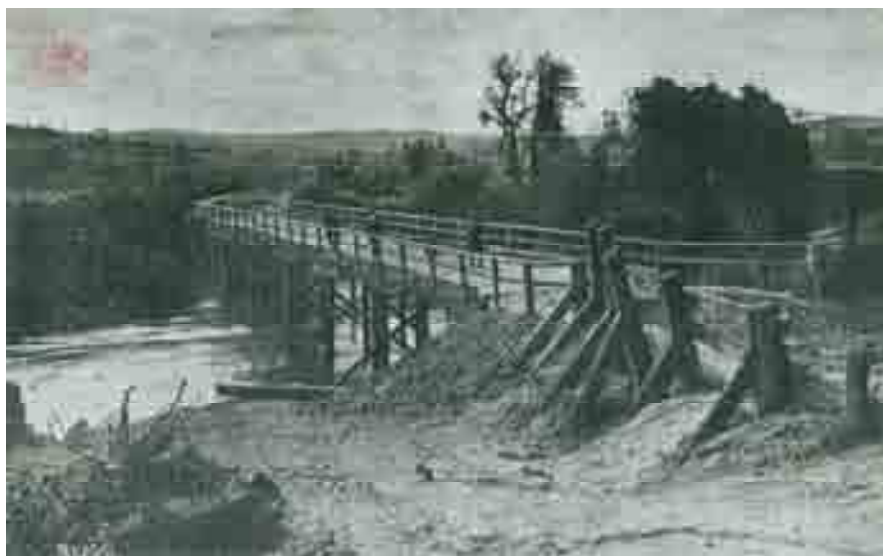
Figura 43 - Ponte de madeira sobre o Arroio Pelotas, recém reconstruída após enchente no mesmo ano, 1923.
